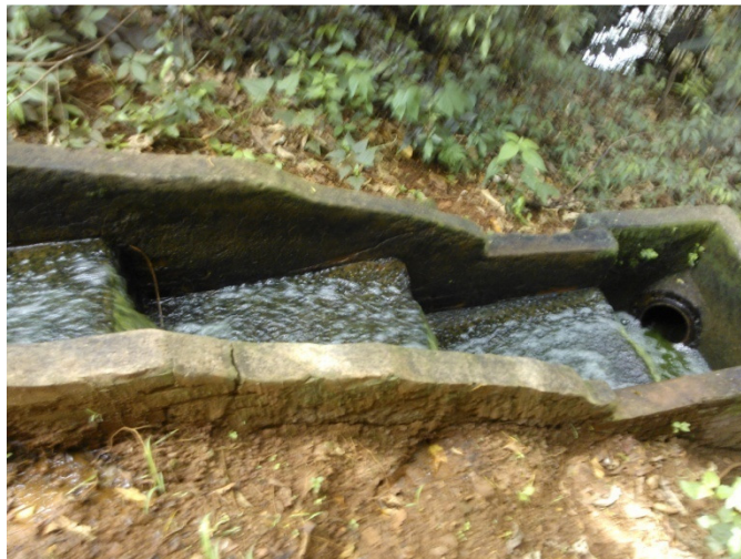
Figura 8: Escada Hidráulica com saída para o Rio Quilombo.
