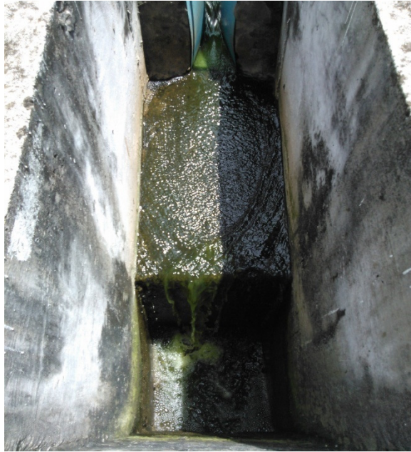
Figura 7: Junção dos afluentes das duas lagoas facultativas e calha Parshall.
