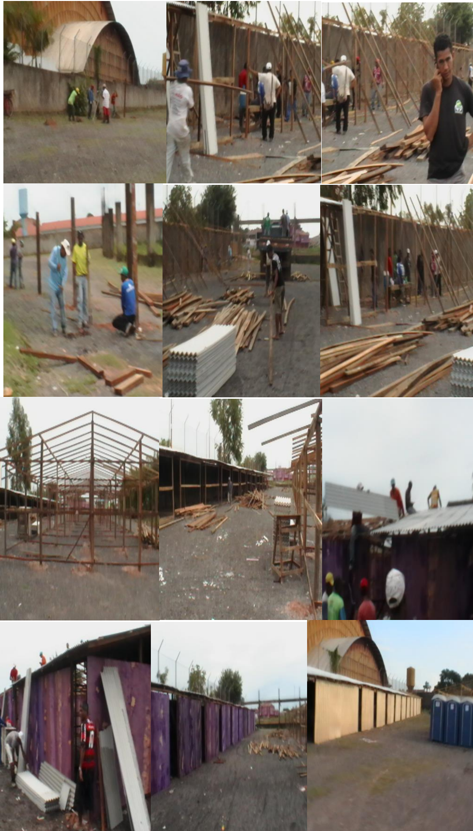
FIGURA 17: ETAPAS DA CONSTRUÇÃO DOS ABRIGOS OFICIAIS PELA COMDEC-MARABÁ
