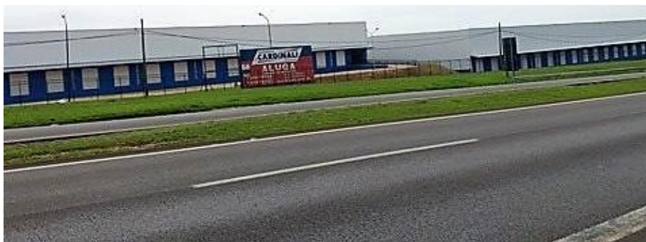
Figura 45-galpões industriais recém construídos dentro dos limites da BHRF. Fonte: próprio autor (2017).
