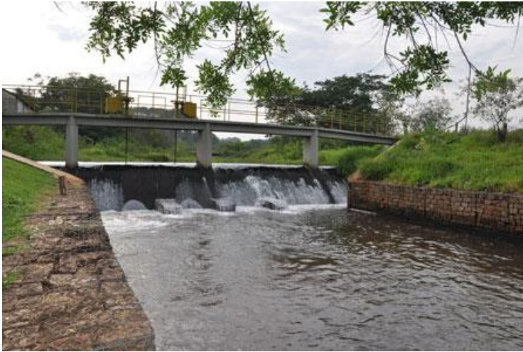
Figura 10- Ponto de captação de água da BHRF para o abastecimento público
