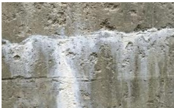
Figura 5 - Fotografia de uma superfície de concreto lixiviada
