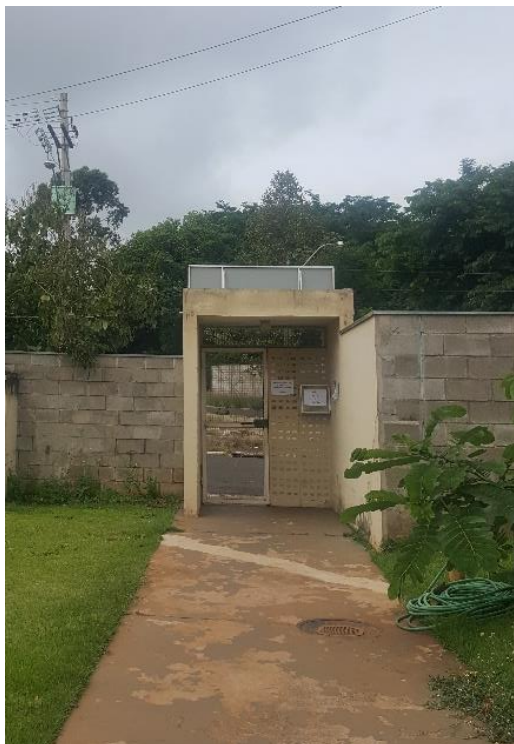
Foto 14: portão do Vila Dignidade visto do interior do condomínio
