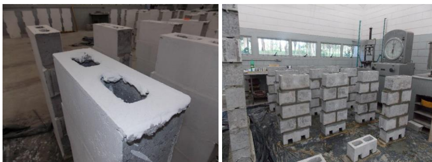
Figura 65– Capeamento do prisma e construção
