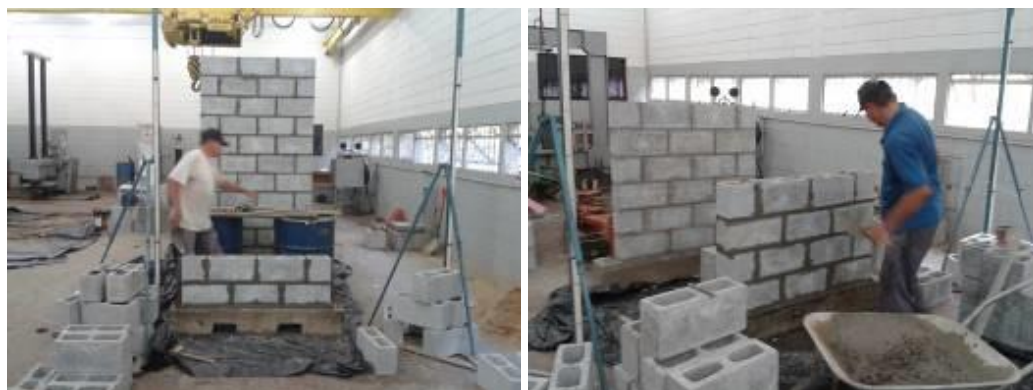
Figura 38. Sequência de montagem das paredes
