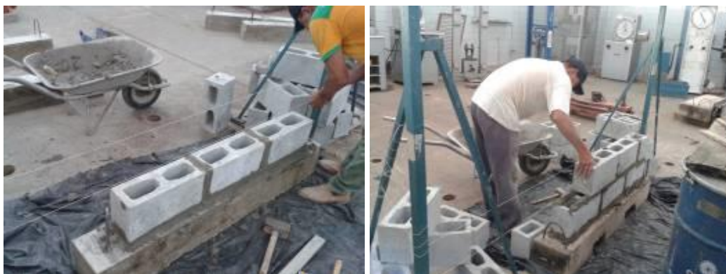
Figura 37. Escantilhões para auxiliar na construção das paredes
