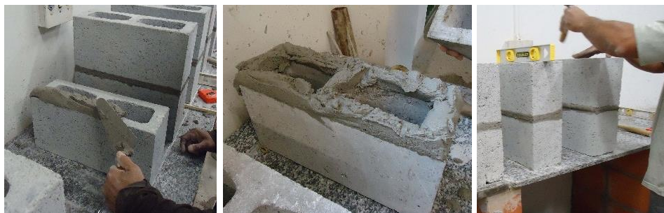
Figura 19. Construção dos prismas
