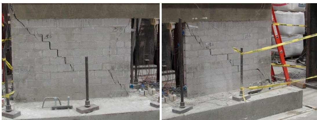
Figura 114 –Forma de ruptura da parede 7 dotada de abertura de porta e acoplada por viga de concreto armado
