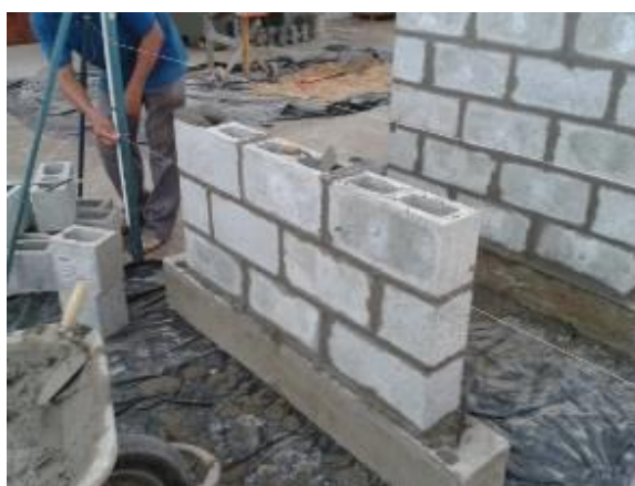
Figura 39. Ilustração das Paredes ocas (sem grauteamento)
