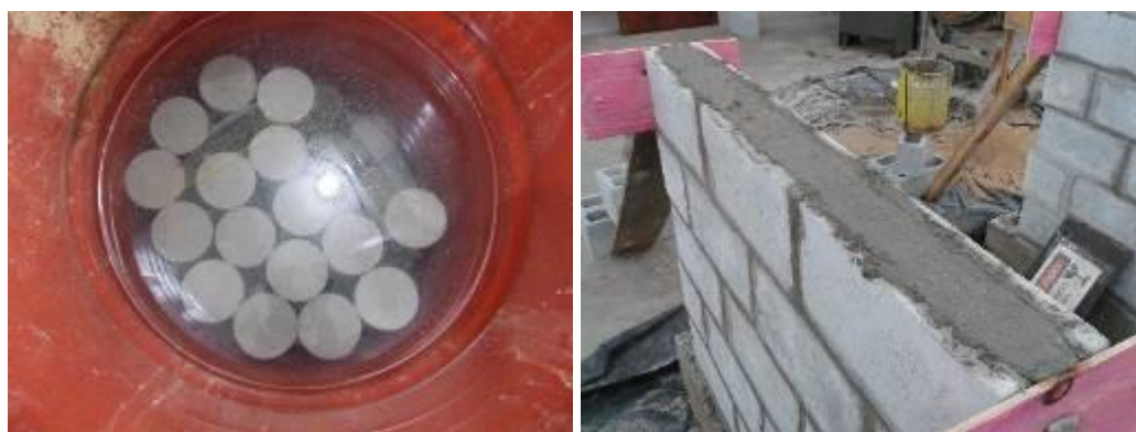
Figura 34. Moldagem dos corpos de prova cilíndricos de graute e grauteamento das paredes.
