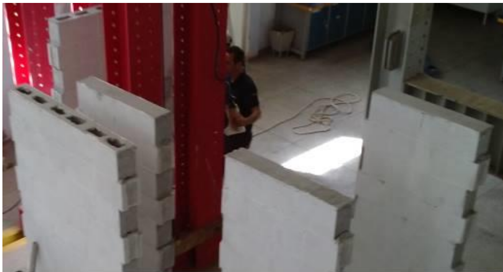
Figura 35. Ilustração do capeamento das paredes com argamassa.
