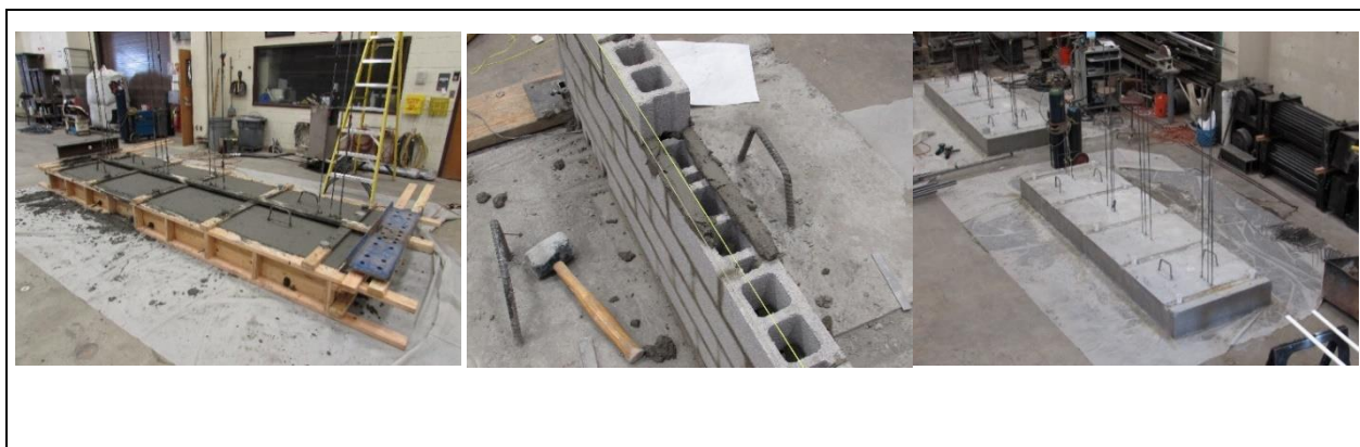
Figura 81– Ilustração da fundação de concreto armado
