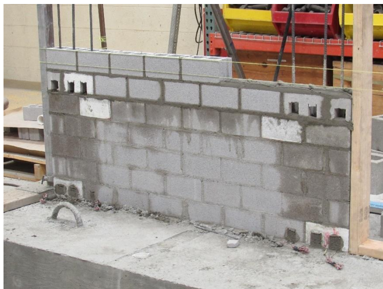
Figura 83 – Grauteado do vazados dos blocos contendo armadura
