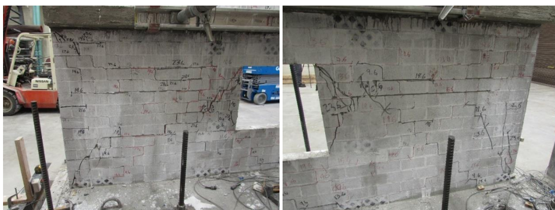
Figura 110 –Forma de ruptura da parede 3 dotada de abertura de janela e acoplada por viga de alvenaria
