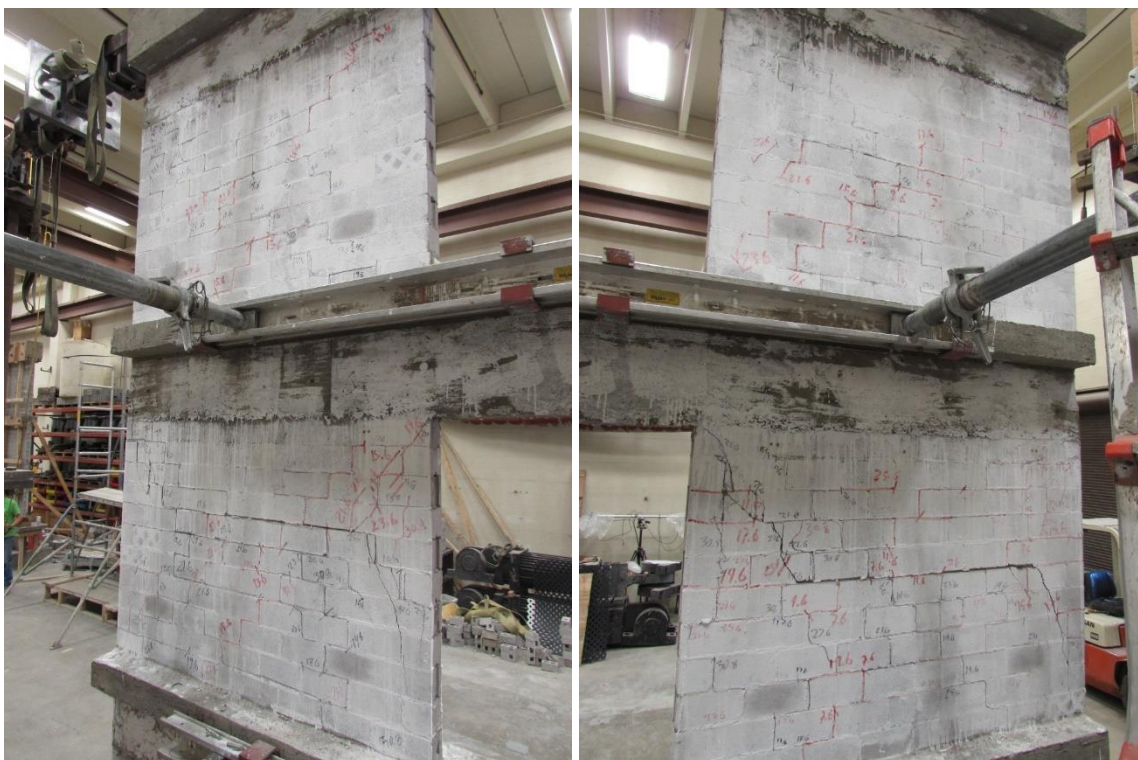
Figura 115 –Forma de ruptura da parede 8 dotada de abertura de janela e acoplada por viga de concreto armado
