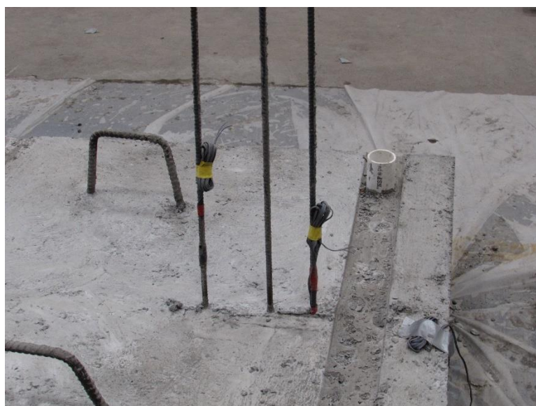
Figura 82 – Ilustração dos armaduras verticais amarrados na base de fundação
