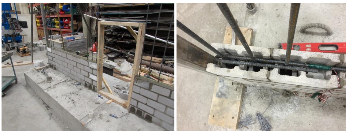
Figura 84 – Grauteamento da viga de alvenaria – Quinta fiada
