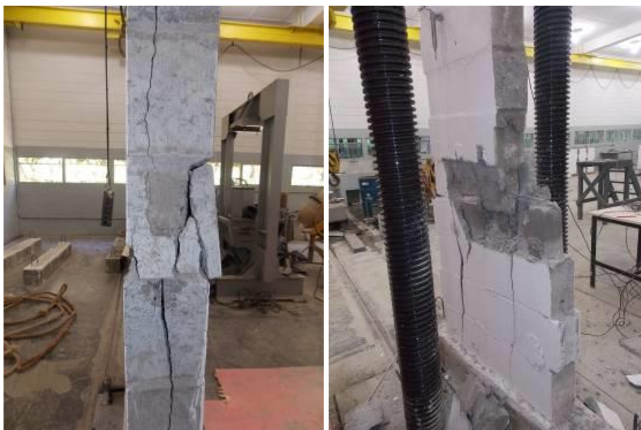
Figura 60. Modo de ruptura das paredes grauteadas
