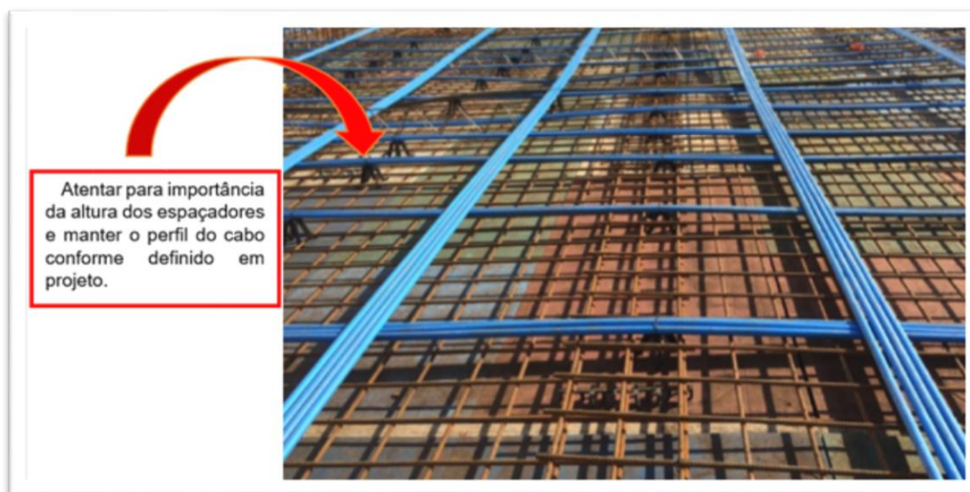
Figura 3-6 - Cordoalhas engraxadas, seus detalhes em laje e espaçadores sob cabos.
