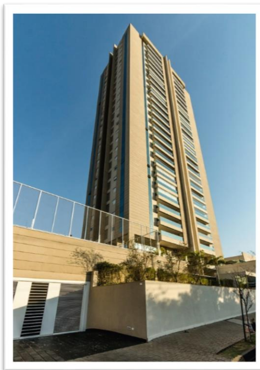
Figura 5-27 – Foto do edifício em perspectiva.
