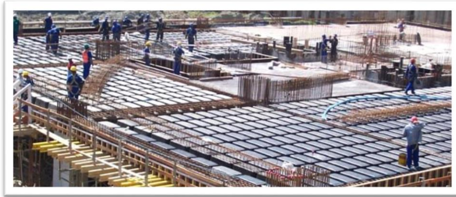
Figura 2-17 – Forma de pavimento em laje nervurada.
