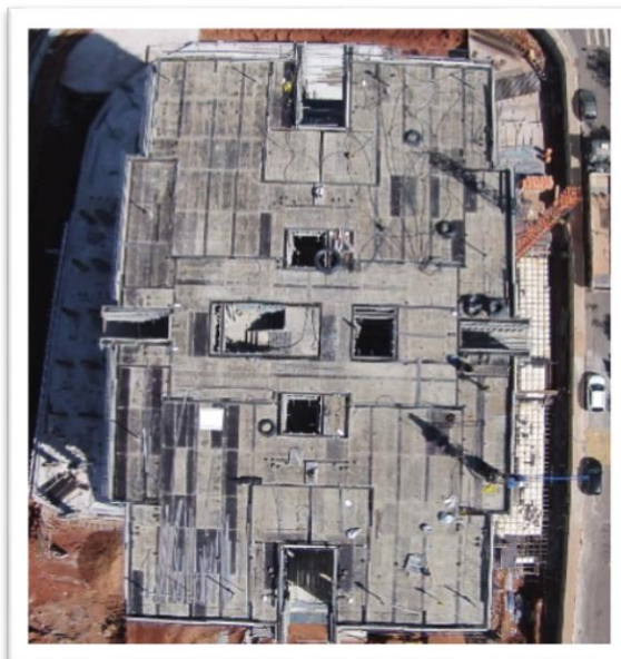
Figura 5-3 - Execução do edifício estudado, formas lajes e vigas.
