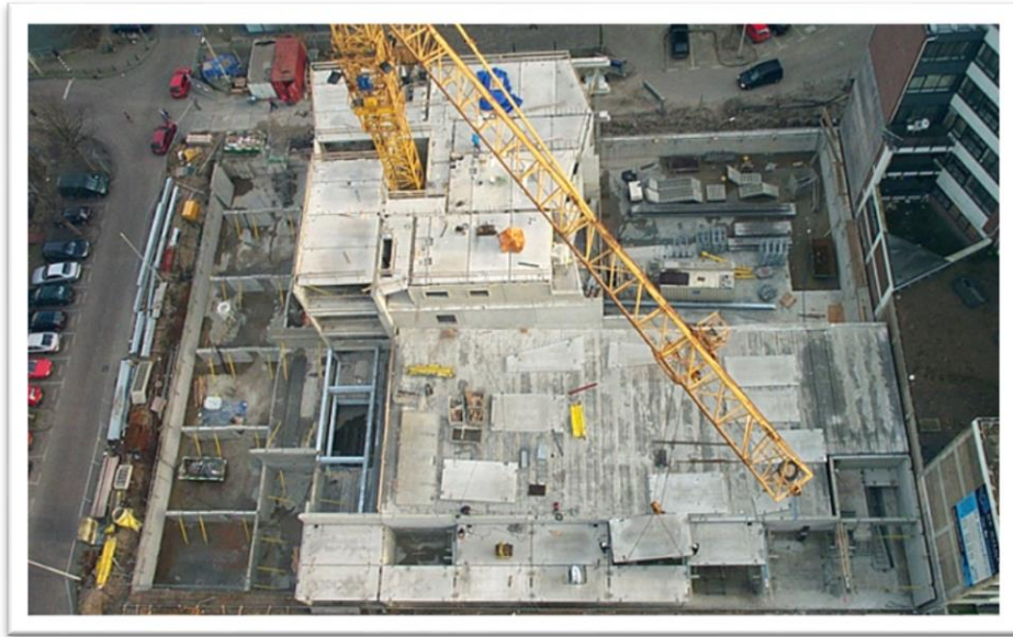
Figura 2-6 – Edifício alto na Bélgica em lajes alveolares com uso de grua de grande porte.
