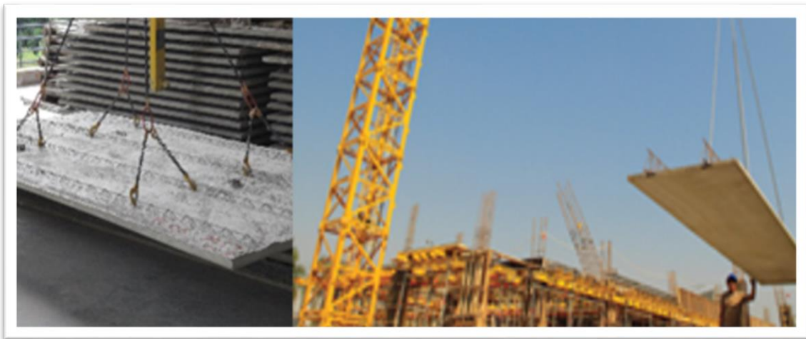
Figura 2-12 – Içamento de pré-laje maciça de concreto com uso de grua.
