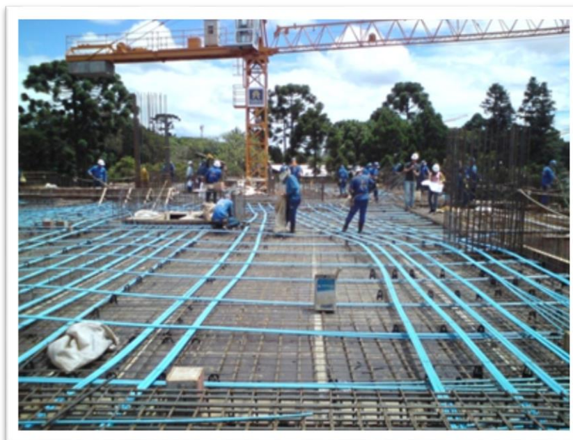
Figura 2-22 - Construção de um pavimento em concreto protendido.
