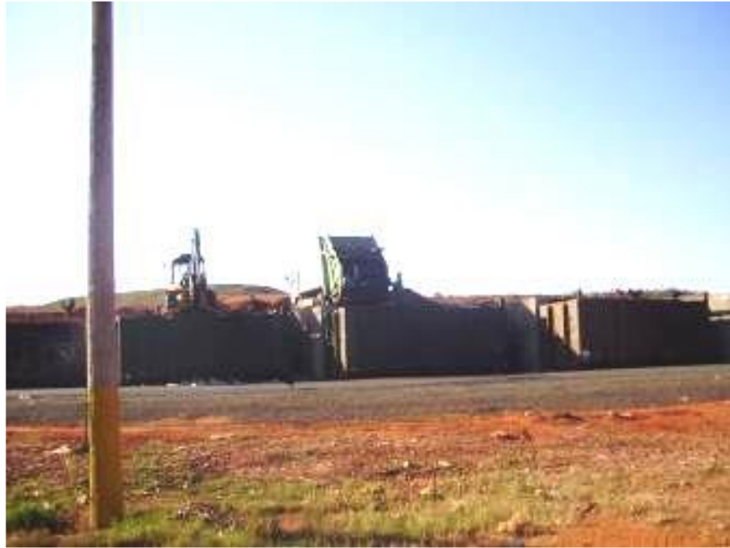
Figura 4.3 - Vista da estação de tratamento de RSD.
