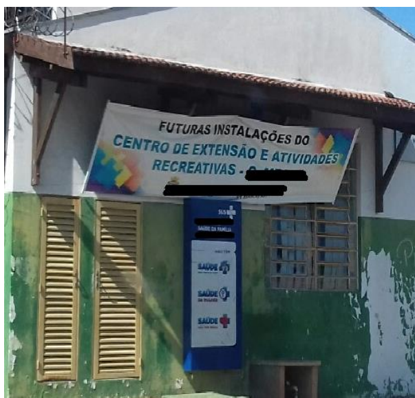
Figura 17: Faixa instalada na antiga Unidade de Saúde
