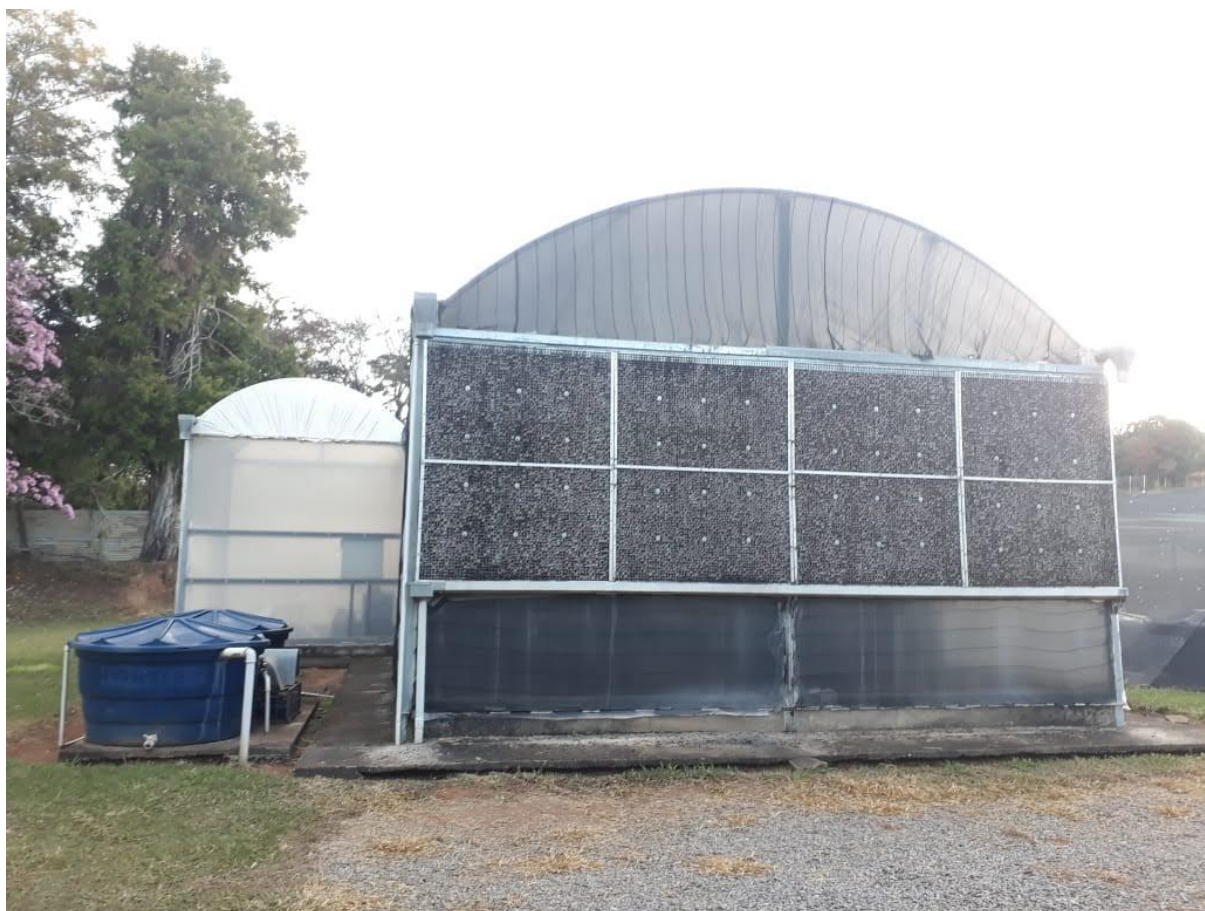
Figura 16 - Casa de vegetação da Fundação Procafé em Varginha - MG.
