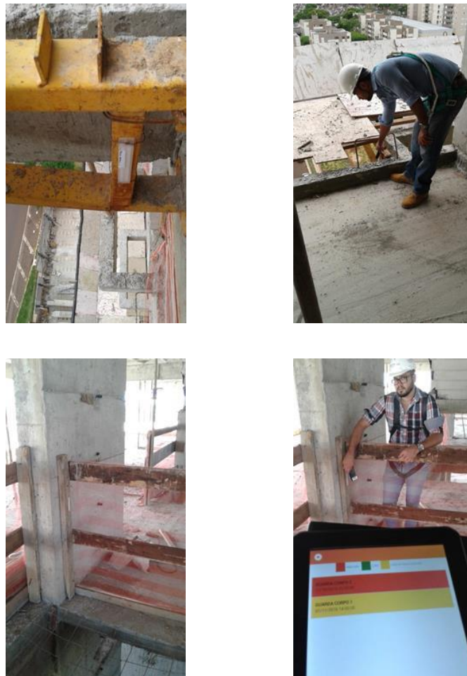
Figura 5.18 – Leitura das Tags instaladas nos equipamentos GcR e Treliza metálica no canteiro de obras
