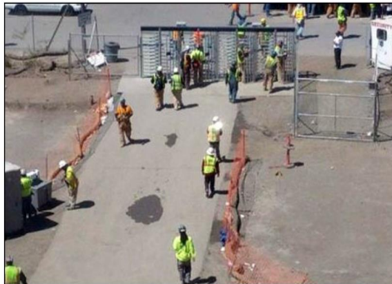
Figura 2.5 – Passagem de trabalhadores pela catraca RFID
