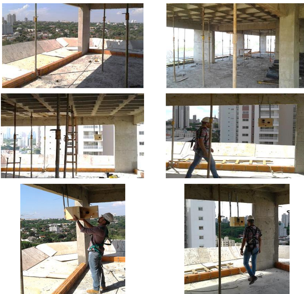
Figura 4.14 – Local do ensaio – 13º pavimento do canteiro de obras do Condomínio Concept Design
