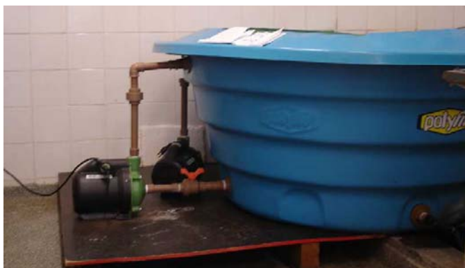
Figura 04. Parte externa do tanque de exercício, para visualização do acoplamento da bomba d'água ao tanque.
