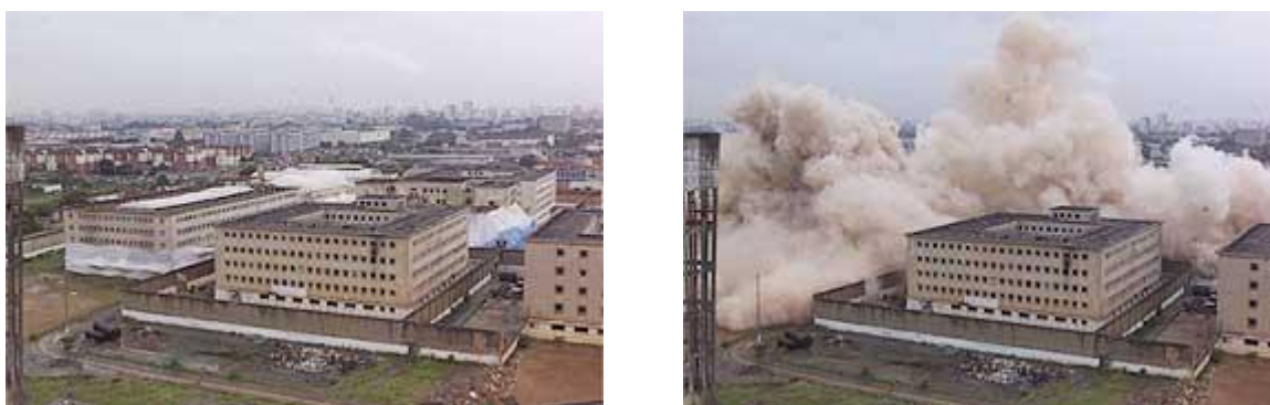
Figura 13 - Implosão dos pavilhões 6, 8 e 9 do complexo penitenciário do Carandiru 12
