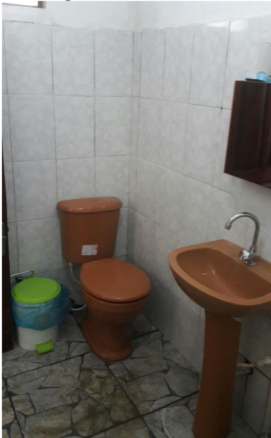
Figura 28 - UEI C – Banheiro
