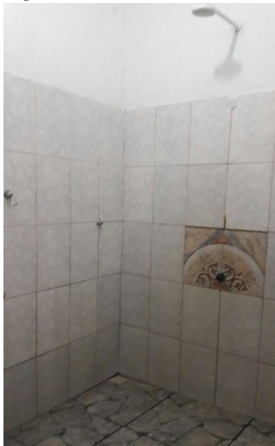
Figura 29 - UEI C – Banheiro – área do chuveiro
