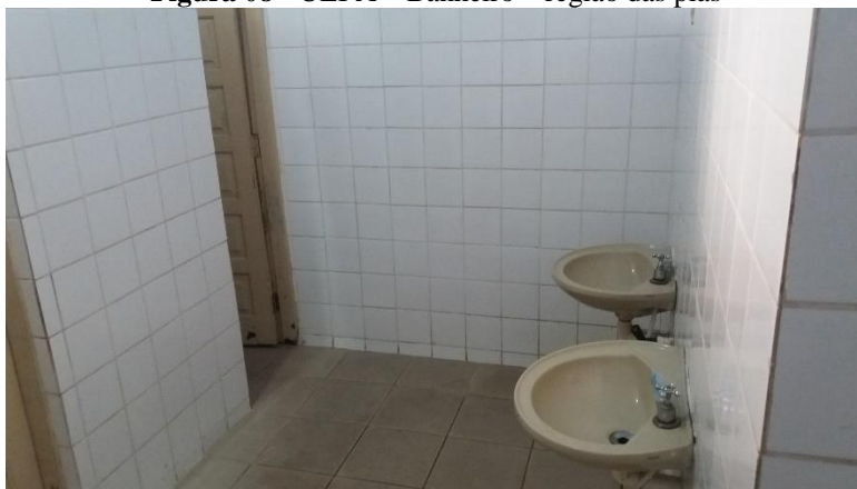
Figura 08 - UEI A – Banheiro – região das pias
