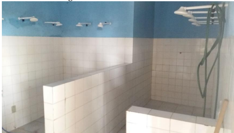
Figura 11 - UEI A – Sala de banho
