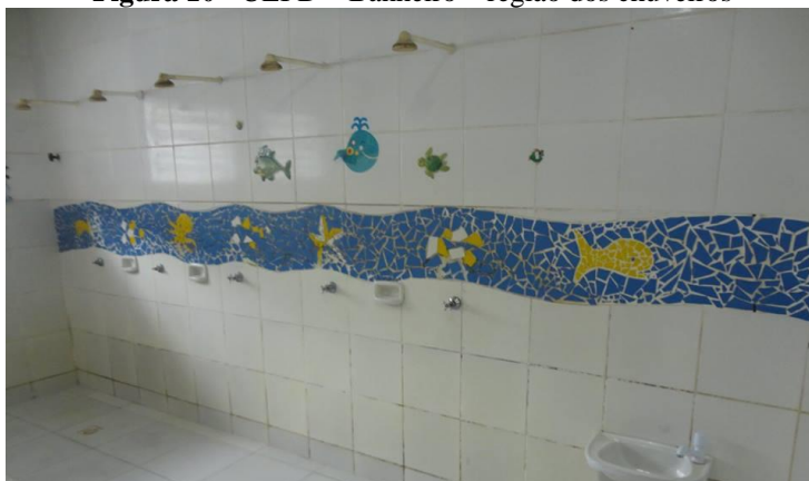
Figura 10 - UEI D – Banheiro – região dos chuveiros
