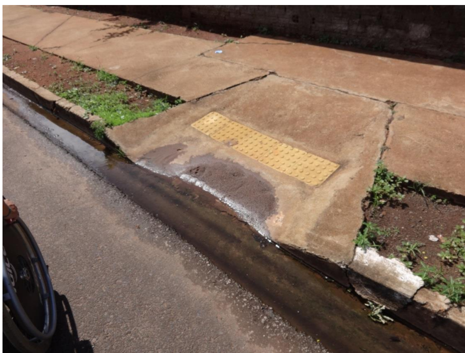
Figura 53 – Rampa de acesso com terra e água
