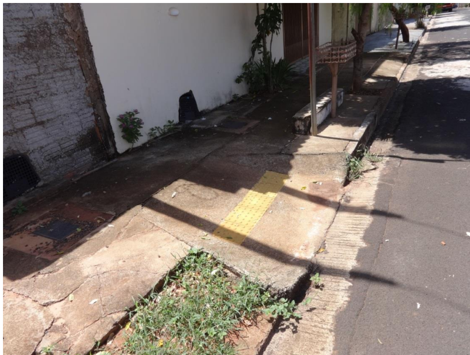
Figura 56– Calçada com rampa de acesso com barreiras para a mobilidade como plantas, lixeiras e piso irregular
