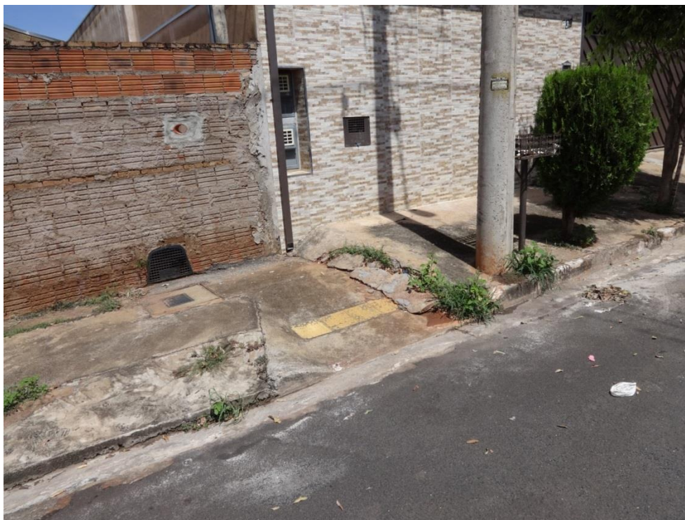
Figura 55 – Rampa de acesso à calçada com barreiras à direita e calçada alta
