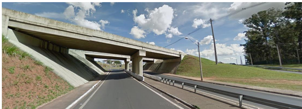
Figura 2.1 – Ponte de concreto armado na rodovia SP-310
