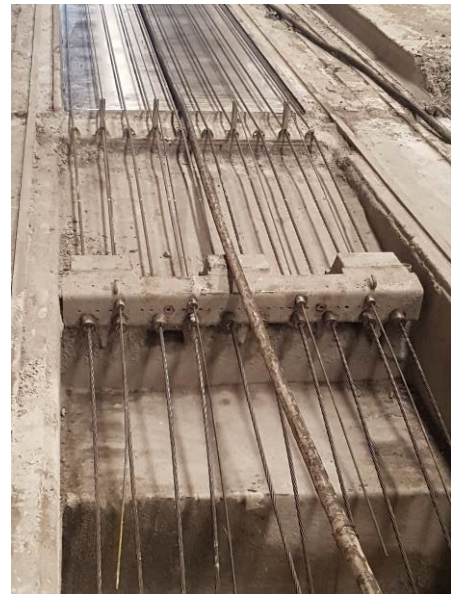
b) Cabos posicionados
