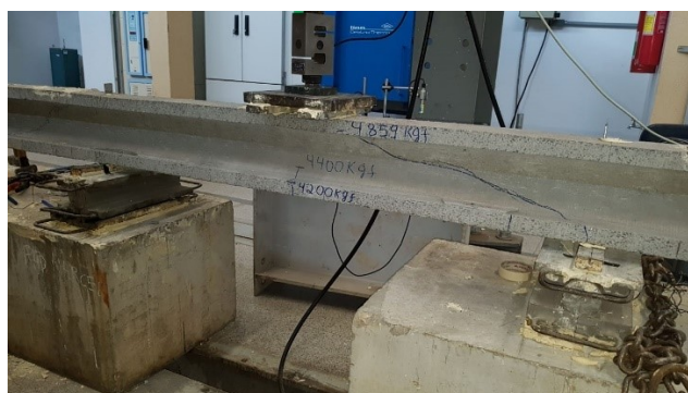
Figura 6-36 - Fissuras do modelo TR3-5
