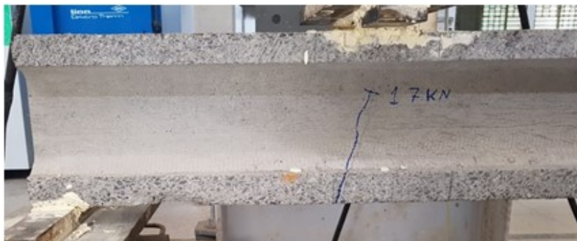
Figura 6-21 - Fissuras do modelo SP-3
