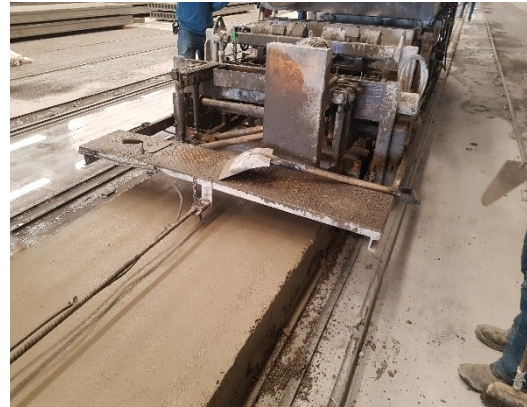
b) Máquina realizando a concretagem
