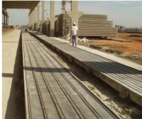
Figura 1-5 - Pista de protensão
