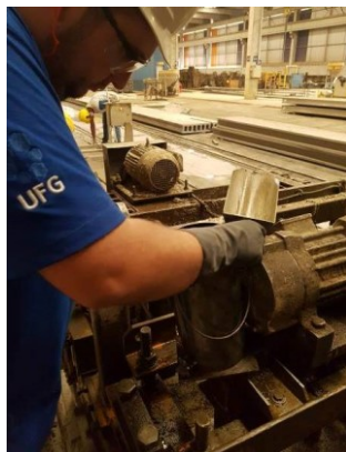
a) Adensamento do concreto nas fôrmas
