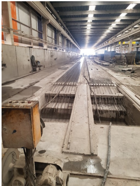
a) Pistas de concretagem
