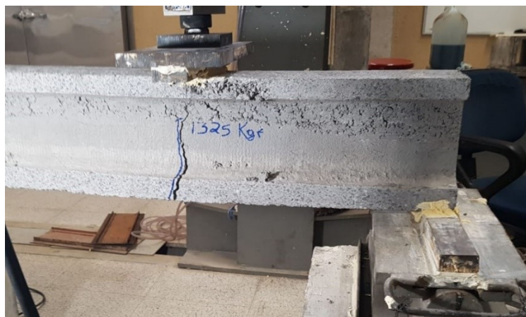
Figura 6-20 - Fissuras do modelo SP-2
