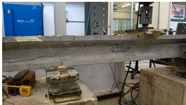
Figura 6-35 - Fissuras do modelo TR3-4
