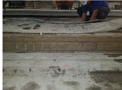
(b) Pinos colados nas quatro faces da laje do trecho 3
