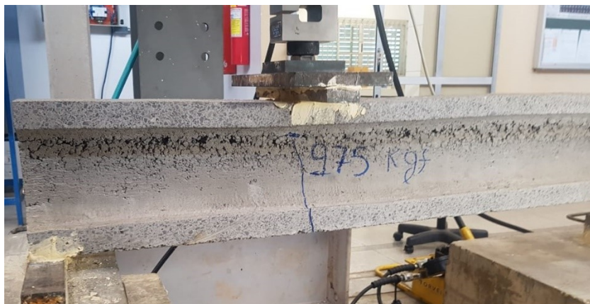
Figura 6-22 - Fissuras do modelo SP-4
