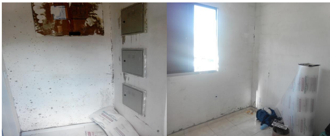
Foto 195 (esquerda) – Escadas para a cobertura por colocar, Bloco B, torre 3, na obra 2 Foto 196 (direita) – Esquadria com vidros por colocar, Bloco C, torre 3, na obra 2 (Fonte: o pesquisador, 2019)
