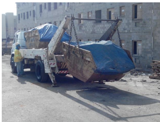
Foto 76 – Resíduos de madeiras (classe B), sendo retirados de canteiro por caminhão poliguindaste (Fonte: o pesquisador, 2019)
