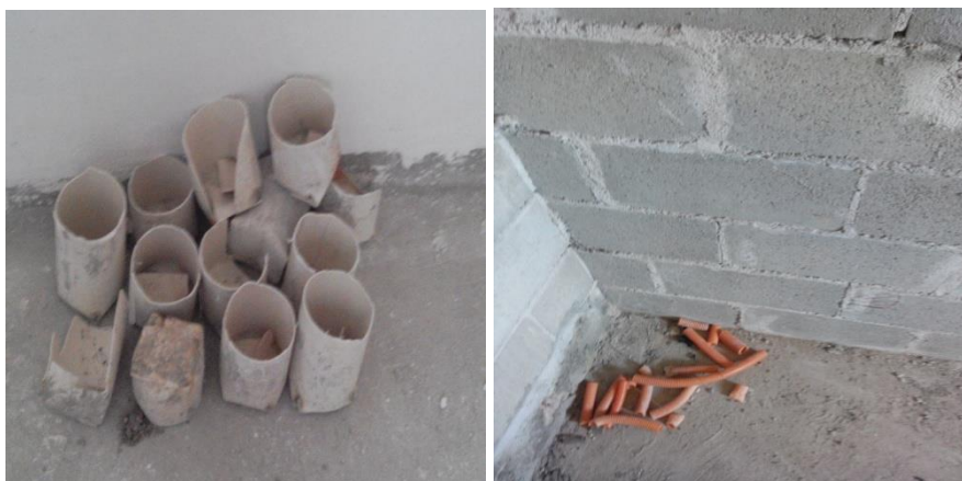
Foto 77 (esquerda) – Tubulação de PVC triada/segregada e inicialmente acondicionada em pequenas pilhas, junto às paredes, nos pavimentos superiores ao térreo; Foto 78 (direita) – Tubo corrugado plástico triado/segregado e inicialmente acondicionado em pequenas pilhas, junto às paredes, nos pavimentos superiores ao térreo (Fonte: o pesquisador, 2019)
