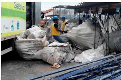
Foto 98 – Retirada de canteiro de sacarias (classe B), por caminhão de caixa fechada, pertencente a empresa municipal de coleta seletiva (Fonte: o pesquisador, 2019)
