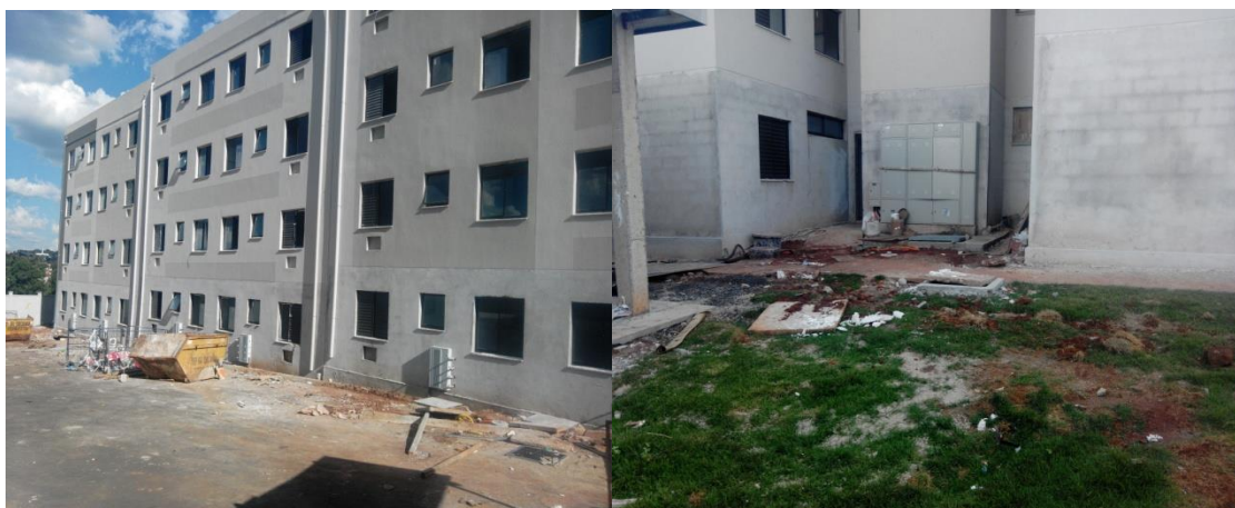
Foto 186 (esquerda) – Aspecto exterior inicial da torre 3, na obra 2; Foto 187 (direita) – Aspecto exterior inicial da torre 3, na obra 2 (Fonte: o pesquisador, 2019)
