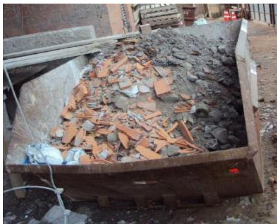
Figura 304 – Caçamba estacionária para o descarte de resíduos (Fonte: Dias, 2013)
