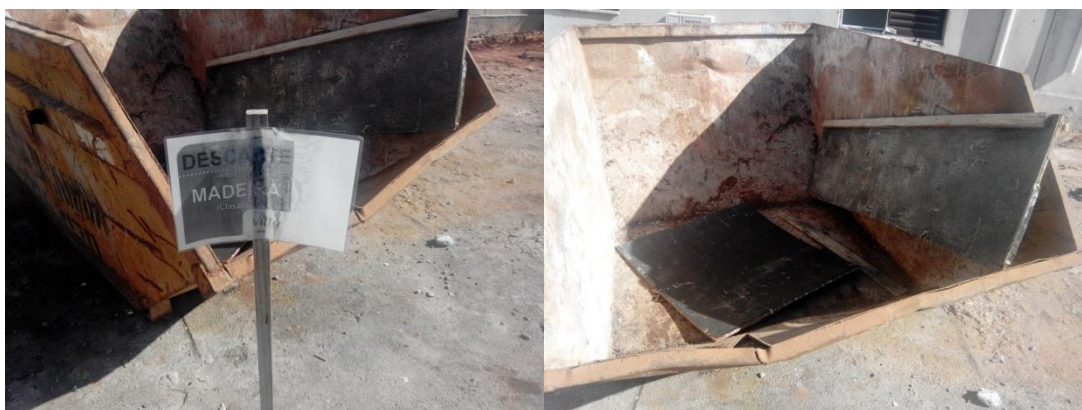
Fotos 137(esquerda) e138 (direita) – Armazenamento final no térreo de madeiras (classe B), em caçambas exclusivas para esse propósito, e na obra 2 (Fonte: o pesquisador, 2019)
