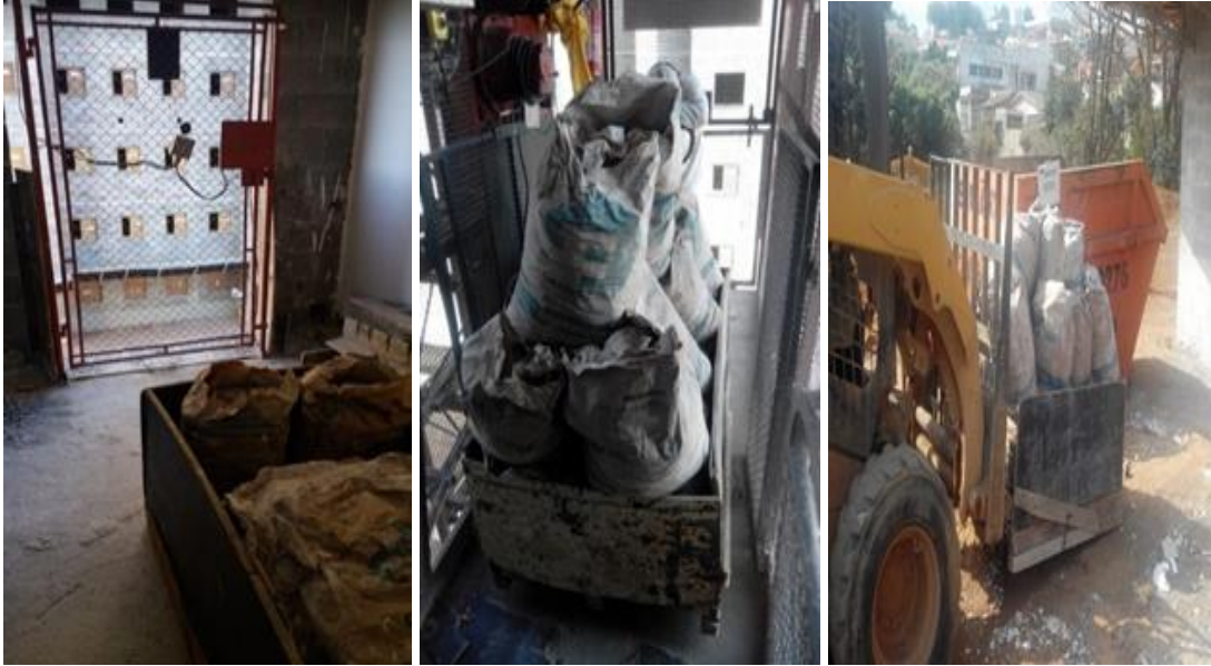
Foto 10 – (esqu.): Gesso (classe B), acondicionamento intermediário; Foto 11 - (centro): Gesso (classe B), instante do transporte vertical para o térreo; Foto 12 – (dir): Gesso (classe B), transporte horizontal no térreo (Fonte: o pesquisador, 2018)
