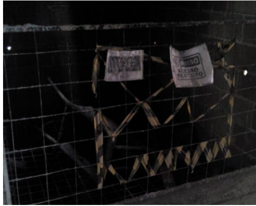
Figura 602 – Zona mal iluminada em caixa de escadas da obra 1, junto ao poço do elevador (pesquisador, 2019)
