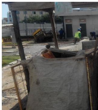
Foto 139 – Armazenamento final de plástico duro em área delimitada para bags, no térreo, na obra 2 (Fonte: o pesquisador, 2019)
