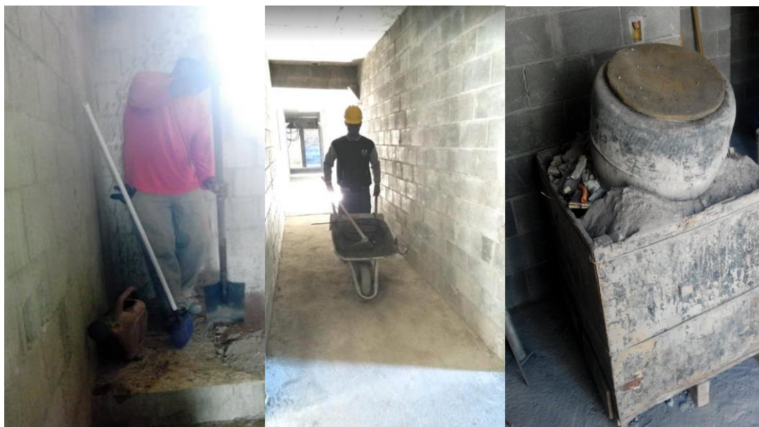
Foto 1 – (esqu.): Cimentícios e cerâmicos (classe A), segregação/triagem inicial; Foto 2 - (centro): Cimentícios e cerâmicos (classe A), transporte horizontal nos pavimentos; Foto 3 - (dir): Cimentícios e cerâmicos (classe A), acondicionamento nos pavimentos (Fonte: o pesquisador, 2018)
