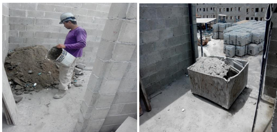
Foto 49 (esquerda) – Resíduos classe A, cimentícios, acondicionados intermediariamente em pilha, em um cômodo com abertura para acesso de “sky-trek”, em pavimento superior ao térreo; Foto 50 (direita) – Resíduos classe A, cimentícios, acondicionados intermediariamente em caixotão de madeira, em um cômodo com abertura para acesso de “sky-trek”, em pavimento superior ao térreo (Fonte: o pesquisador, 2019)
