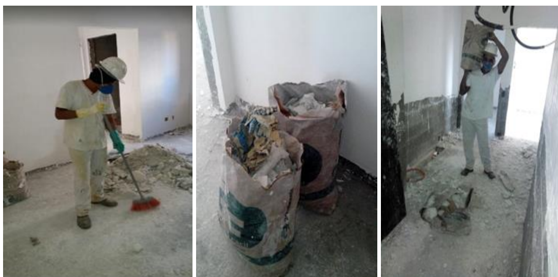
Foto 7 – (esq.): Gesso (classe B), segregação/ triagem inicial; Foto 8 - (centro): Gesso (classe B), acondicionamento inicial nos pavimentos; Foto 9 – (dir): Gesso (classe B), transporte horizontal nos pavimentos (Fonte: o pesquisador, 2018)
