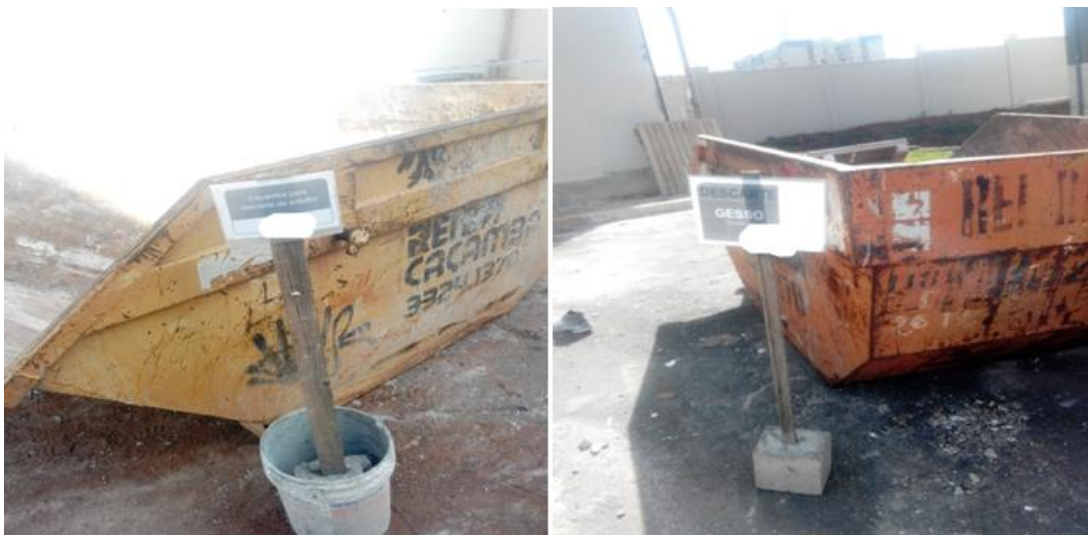
Foto 191 (esquerda) – Caçamba para armazenamento final de entulhos, praticamente vazia, na obra 2; Foto 192 (direita) – Caçamba para armazenamento final de gesso praticamente vazia, na obra 2 (Fonte: o pesquisador, 2019)
