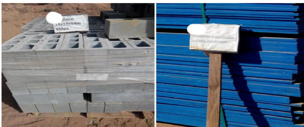
Fotos 24 (esqu.) e 25 (dir.) - Zonas de estocagem de materiais perfeitamente definidas/delimitadas, e com os respectivos materiais bem identificados (Fonte: o pesquisador)
