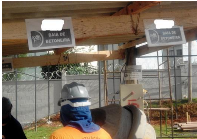
Foto 190 – Única betoneira a funcionar na obra 2 (Fonte: o pesquisador, 2019)
