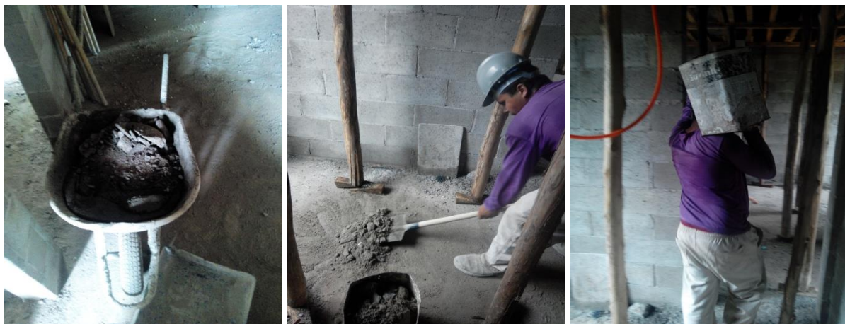
Foto 46 (esquerda) – Resíduos classe A, cimentícios, coleta por jericas, em piso superior ao térreo; Foto 47 (centro) - Resíduos classe A, cimentícios, coleta em latas, em piso superior ao térreo; Foto 48 (direita) – Resíduos classe A, transporte manual em latas, em piso superior ao térreo (Fonte: o pesquisador, 2019)
