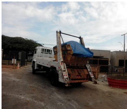
Foto 69 – Resíduos de gesso (classe B), sendo retirados de canteiro por caminhão poliguindaste (Fonte: o pesquisador, 2019)
