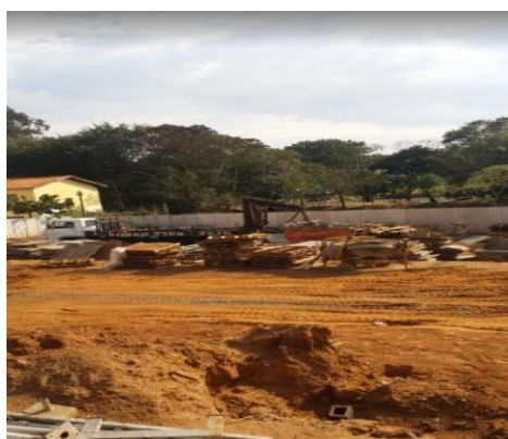
Foto 16 – Madeira grossa (classe B), instante de remoção e transporte para fora do canteiro (Fonte: o pesquisador, 2018)
