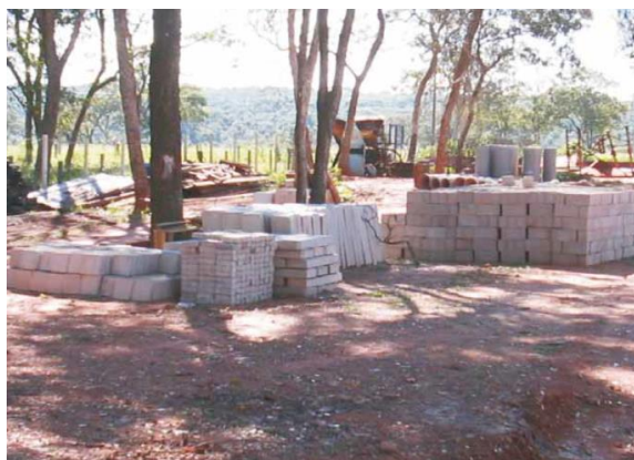
Figura 312 – Confeção de blocos com agregados reciclados (Fonte: Lima e Lima, 2012)
