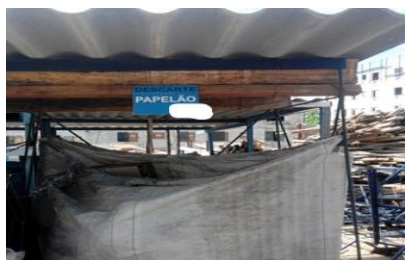
Foto 95 – Armazenamento final de papéis e papelões (classe B) em área delimitada para bags, no térreo (Fonte: o pesquisador, 2019)
