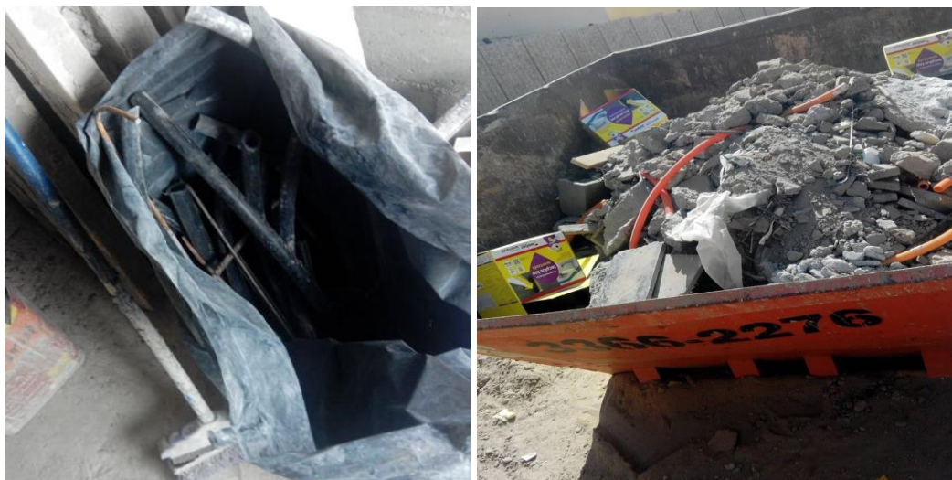
Foto 20 - (esq.): Materiais plásticos (classe B), acondicionamento intermediário nos pavimentos (contaminados com pontas de aço); Foto 21 – (dir): Materiais plásticos (classe B), armazenamento final no térreo, contaminados com materiais de outros tipos (Fonte: o pesquisador, 2018)
