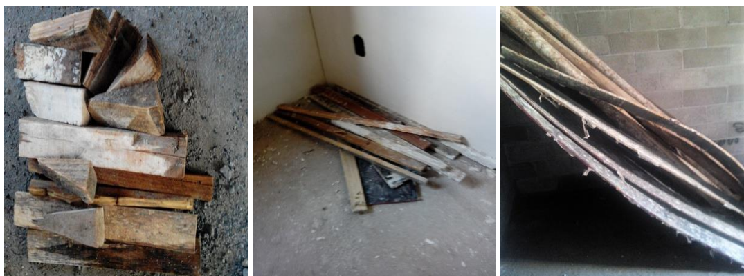
Foto 70 (esquerda) – Resíduos de pequenos pedaços de madeira, triados e acondicionados em área central de cômodo, nos pavimentos superiores ao térreo; Foto 71 (centro) - Resíduos de madeiras de médias dimensões, triados e acondicionados junto a parede em cômodo, nos pavimentos superiores ao térreo; Foto 72 (direita) – Resíduos de
