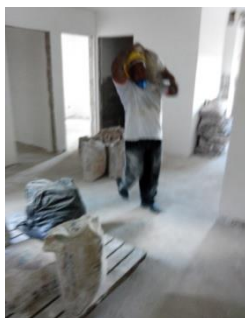
Foto 65 – Transporte inicial horizontal, nos pavimentos superiores ao térreo, feito manualmente pelos funcionários, de resíduos de gesso (classe B) (Fonte: o pesquisador, 2019)
