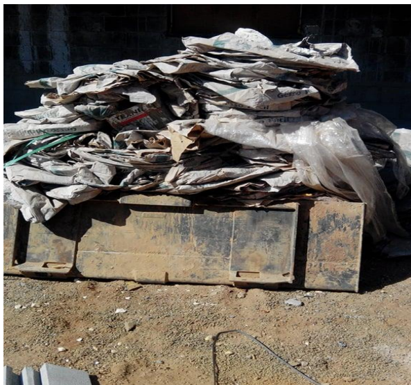
Foto 19 – Papeis e papelões (classe B), armazenamento final no piso térreo (Fonte: o pesquisador, 2018)
