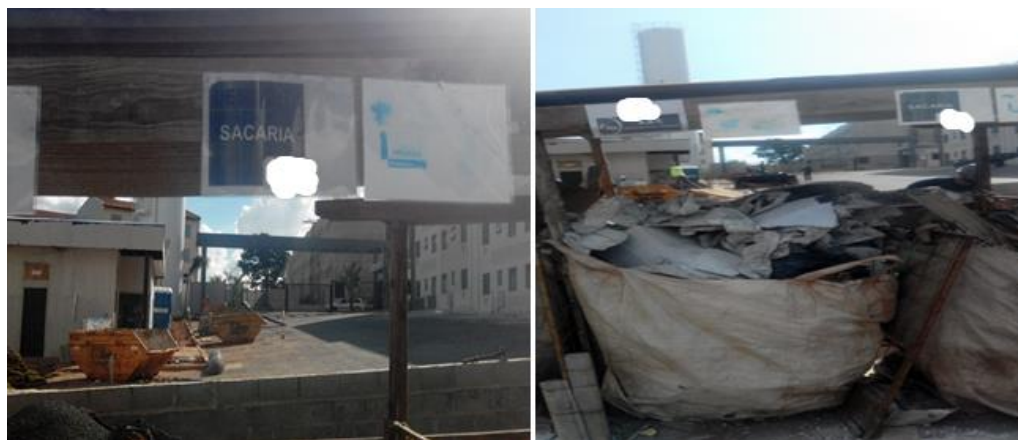
Fotos 145(esquerda) e 146 (direita) – Armazenamento final de sacarias (classe B) em área delimitada para bags, no piso térreo da obra 2 (Fonte: o pesquisador, 2019)
