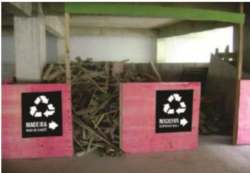
Figura 303 – Baias para o descarte de resíduos (Fonte: Scalone, 2013)
