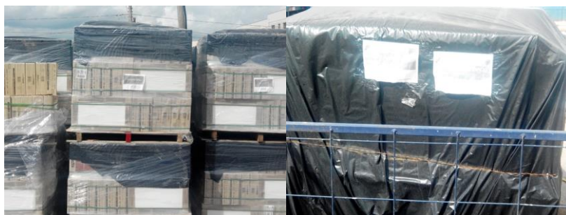
Foto 105 (esquerda) – Áreas de estocagem de materiais perfeitamente delimitadas, com os mesmos protegidos contra intempéries, exemplo 1; Foto 106 (direita) – Áreas de estocagem de materiais perfeitamente delimitadas, com os mesmos protegidos contra intempéries, exemplo 2 (Fonte: o pesquisador, 2019)
