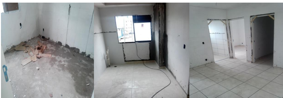
Foto 245 (esquerda)– Aspecto de limpeza em quarto, Torre 2, Bloco C, térreo, na obra 2; Foto 246 (centro) – Aspecto de limpeza em cozinha, Torre 2, bloco C, térreo, na obra 2; Foto 247 (direita) – Aspecto de limpeza em sala, Torre 2, bloco C, térreo, na obra 2 (Fonte: o pesquisador, 2019)
