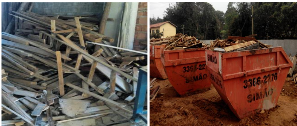
Foto 14 - (esq.): Madeira grossa (classe B), triagem/segregação inicial; Foto 15 – (dir): Madeira grossa (classe B), armazenamento final no térreo (Fonte: o pesquisador, 2018)
