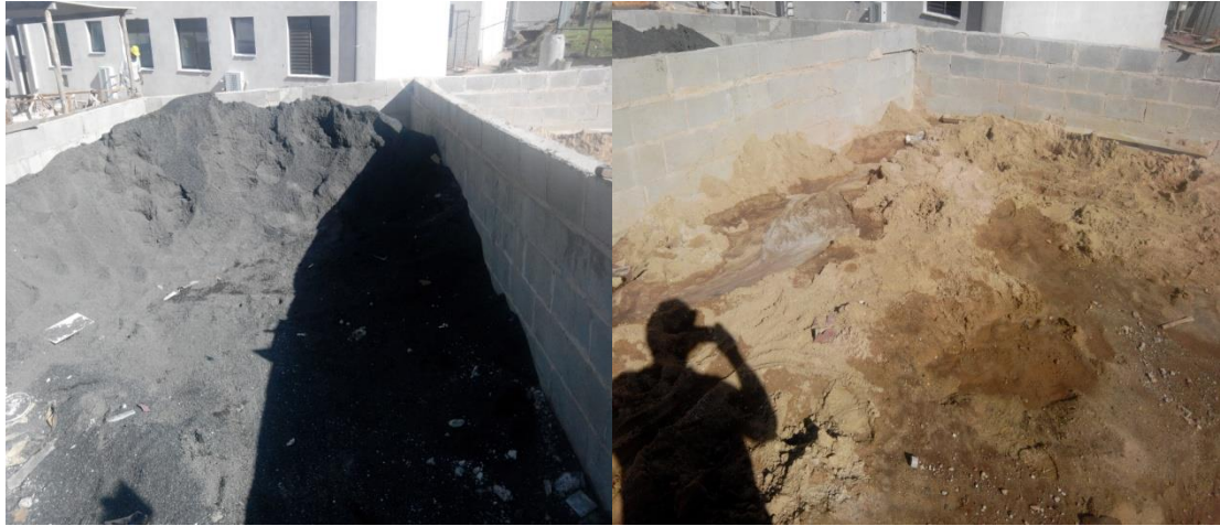
Foto 188 (esquerda) – Baia de pedrisco semi-vazia, na obra 2; Foto 189 (direita) – Baia de areia praticamente vazia, na obra 2 (Fonte: o pesquisador, 2019)
