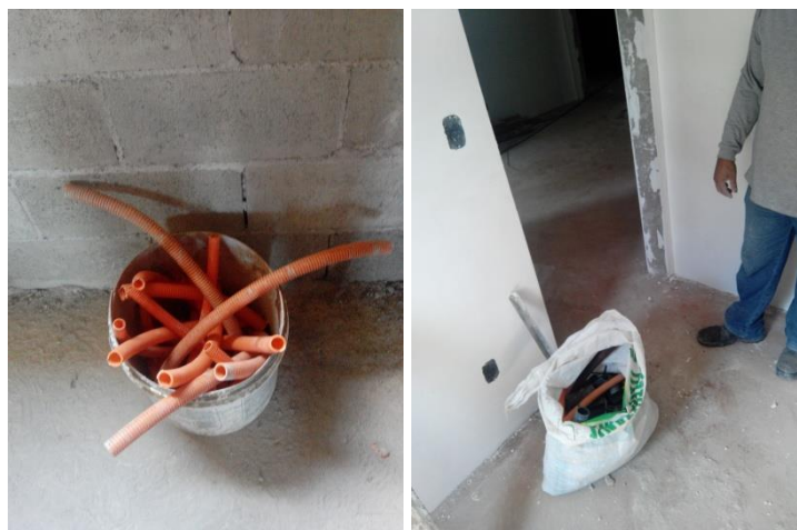
Foto 79 (esquerda) – Tubo corrugado plástico já acondicionado, depois de transferido, em balde, nos pavimentos superiores ao térreo; Foto 80 (direita) – Materiais plásticos duros/rígidos já acondicionados, depois de transferidos, em saco de ráfia, nos pavimentos superiores ao térreo (Fonte: o pesquisador, 2019)
