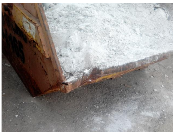
Foto 68 – Caçamba de gesso, no térreo, para armazenamento final exclusivo desse tipo de material (Fonte: o pesquisador, 2019)
