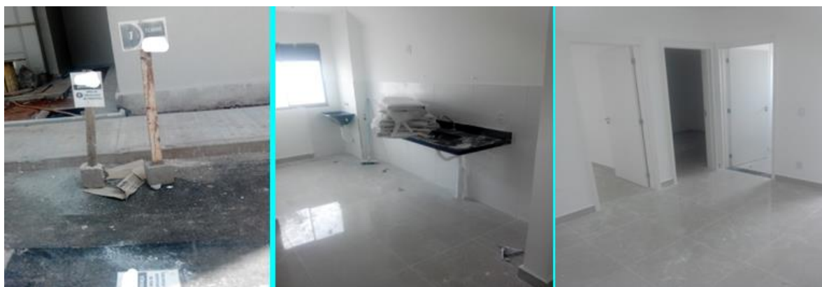
Foto 227 (esquerda)– Sinalética de Torre 1 e circulação para pedestres, bloco D, térreo, na obra 2; Foto 228 (centro) – Aspecto de limpeza em cozinha, Torre 1, bloco D, térreo, na obra 2; Foto 229 (direita) – Aspecto de limpeza em sala, Torre 1, bloco D, térreo, na obra 2 (Fonte: o pesquisador, 2019)
