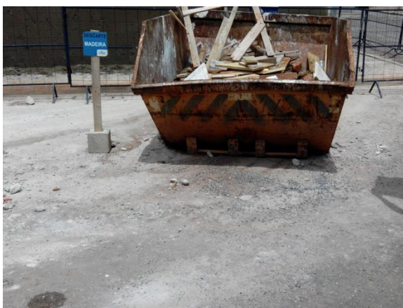
Foto 75 – Armazenamento final de resíduos de madeira, em caçambas exclusivas para eles, no térreo (Fonte: o pesquisador, 2019)
