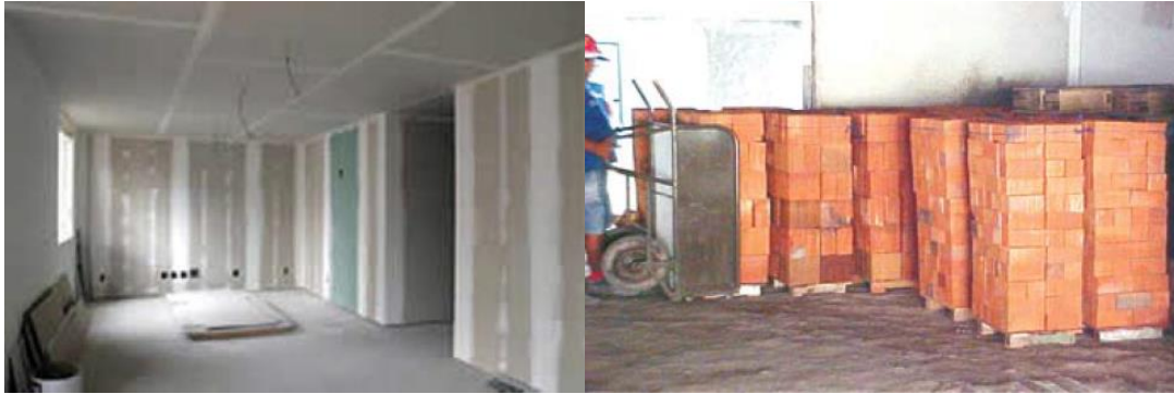
Figura 8 – (esquerda) Uso de materiais tipo “dry-wall”; (direita) Paletização (Fonte: Novaes, M. de V.; Mourão, C.A.M. do A., 2008)
