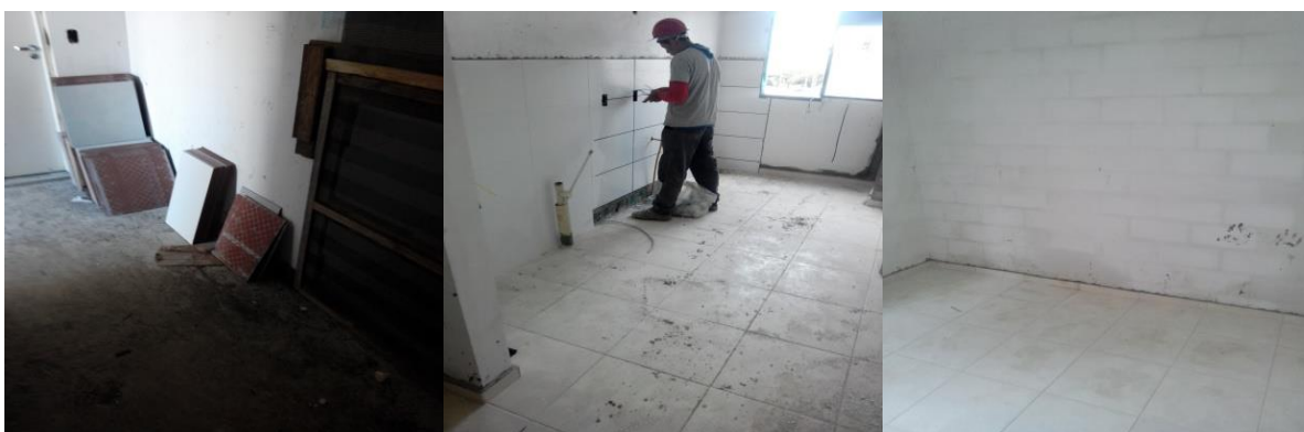
Foto 251 (esquerda)– Aspecto de limpeza em área comum, Torre 2, Bloco C, 3º piso, na obra 2; Foto 252 (centro) – Aspecto de limpeza em cozinha, Torre 2, Bloco C, 3º piso, na obra 2; Foto 253 (direita) – Aspecto de limpeza em quarto, Torre 2, Bloco C, 3º piso, na obra 2 (Fonte: o pesquisador, 2019)
