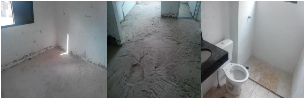
Foto 260 (esquerda)– Aspecto de limpeza em quarto, Torre 3, Bloco B, 1º piso, na obra 2; Foto 261 (centro) – Aspecto de limpeza em sala, Torre 3, Bloco B, 1º piso, na obra 2; Foto 262 (direita) – Aspecto de limpeza em banheiro, Torre 3, Bloco B, 1º piso, na obra 2 (Fonte: o pesquisador, 2019)
