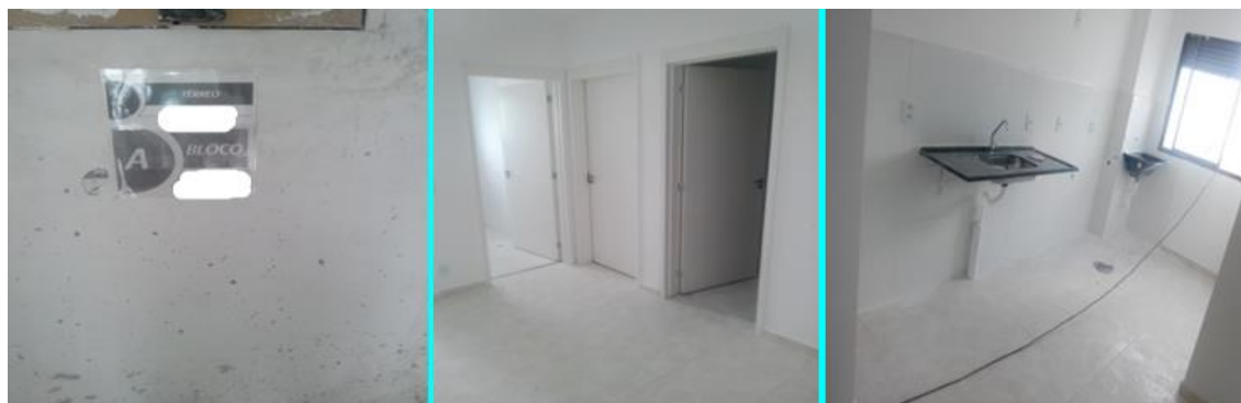
Foto 209 (esquerda)– Sinalética na Torre 1, bloco A, piso térreo, na obra 2; Foto 210 (centro) – Aspecto de limpeza na sala, torre 1, bloco A, térreo, na obra 2; Foto 211 (direita)– Aspeto de limpeza na cozinha, torre 1, bloco A, térreo, na obra 2(Fonte: o pesquisador, 2019)
