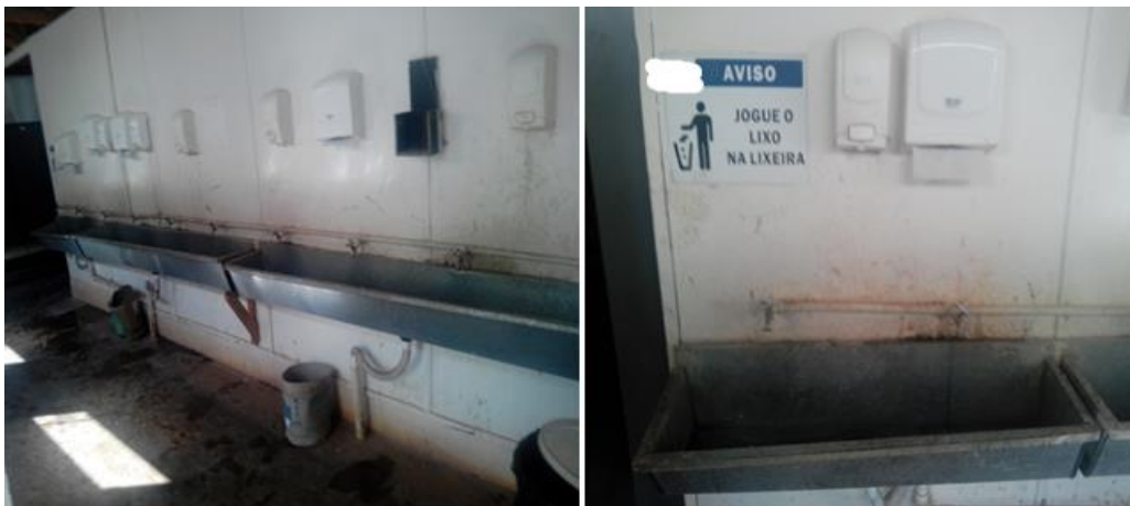
Foto 163 (esquerda) – Aspetto geral de organização e limpeza nos sanitários da obra 2, foto1/2; Foto 164 (direita) – Aspetto geral de organização e limpeza nos sanitários da obra 2, foto 2/2 (Fonte: o pesquisador, 2019)
