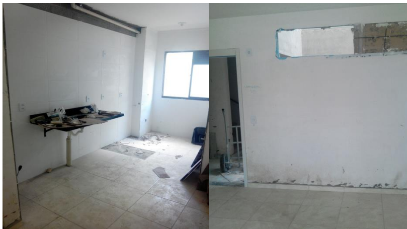
Foto 205 (esquerda) – Sanca em teto de cozinha por executar, e tanquinho por assentar, Bloco A, torre 1, na obra 2; Foto 206 (direita) – Esquadrias por terminar, em sala, Bloco B, torre 1, na obra 2 (Fonte: o pesquisador, 2019)
