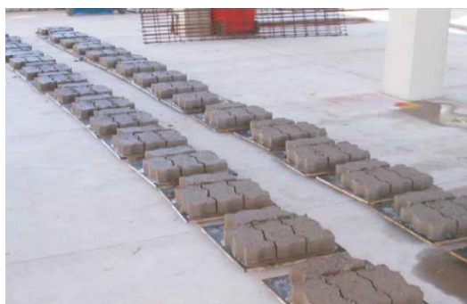
Figura 311 – Confeção de pavers com agregados reciclados (Fonte: Lima e Lima, 2012)
