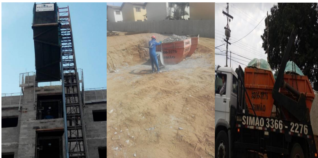
Foto 4 – (esq.): Cimentícios e cerâmicos (classe A), transporte vertical para o térreo; Foto 5 - (centro): Cimentícios e cerâmicos (classe A), transporte horizontal e armazenamento final no térreo; Foto 6 – (dir): Cimentícios e cerâmicos (classe A), remoção e transporte para fora do canteiro (Fonte: o pesquisador, 2018)
