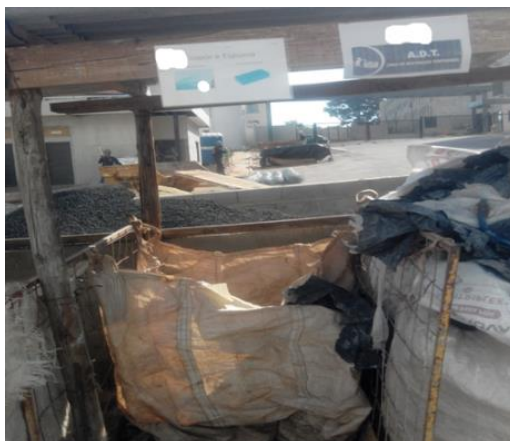
Foto 142 – Armazenamento final de isopor (classe B) em área delimitada para bags, no térreo da obra 2 (Fonte: o pesquisador, 2019)
