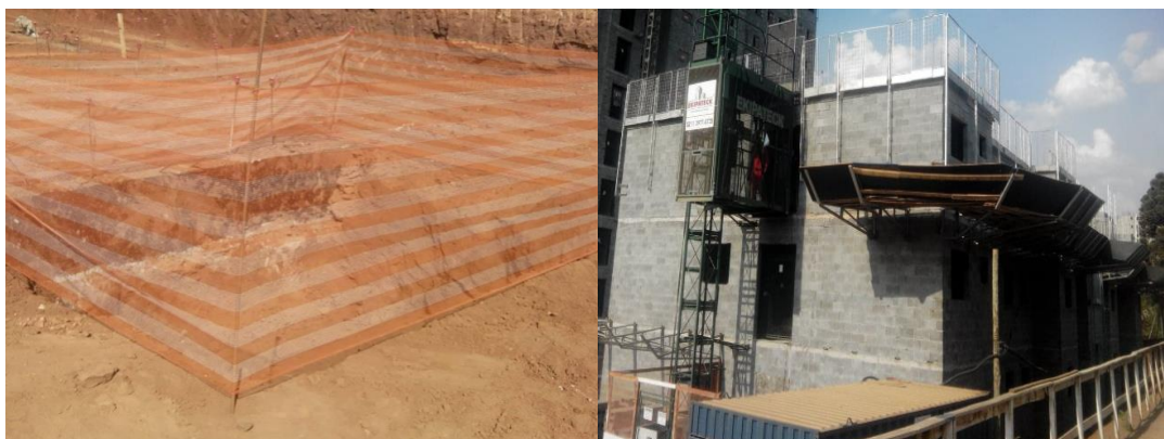
Foto 29 (esq.) - Elementos de proteção contra quedas e depressões/valas/escavações para fundação; Foto 30 (dir.) - Proteções metálicas anti-queda no perímetro exterior, no levantamento das paredes de alvenaria estrutural (o pesquisador)
