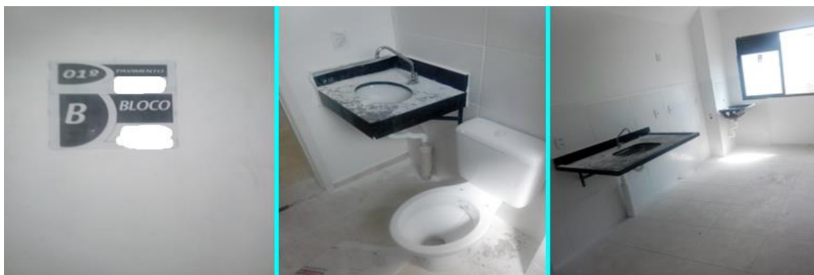
Foto 215 (esquerda)– Sinalética na Torre 1, bloco B, 1º piso, na obra 2; Foto 216 (centro) – Aspecto de limpeza no banheiro, torre 1, bloco B, 1º piso, na obra 2; Foto 217 (direita) – Aspecto de limpeza em cozinha, torre 1, bloco B, 1º piso, na obra 2(Fonte: o pesquisador, 2019)
