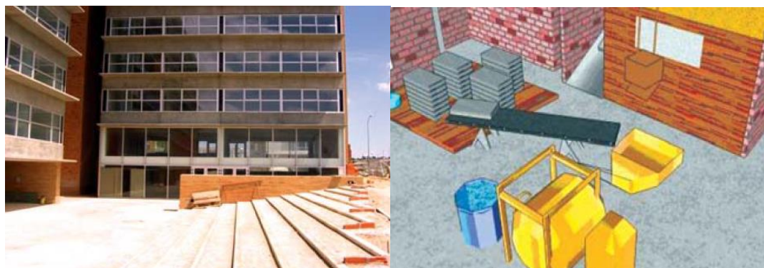
Figura 10 – (esquerda) Obra limpa e organizada; (direita) Racionalização da estação de trabalho da betoneira (Fonte: Novaes, M. de V.; Mourão, C.A.M. do A., 2008)
