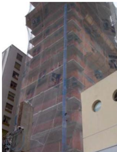
Figura 306 – Coletor vertical de resíduos (Fonte: Scalone, 2013)
