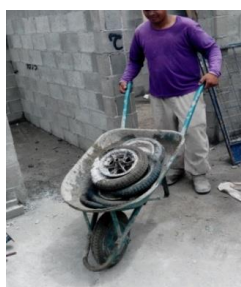
Foto 100 – Coleta e transporte inicial horizontal de pneus inservíveis, nos pavimentos superiores ao térreo (Fonte: o pesquisador, 2019)
