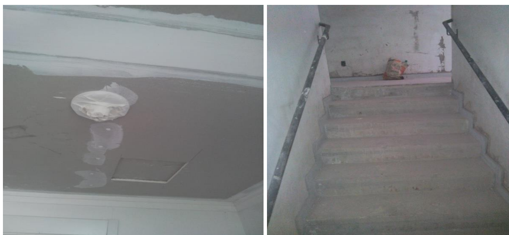
Foto 197 (esquerda) – Execução de teto falso em banheiro, Bloco A, torre 2, na obra 2; Foto 198 (direita) – Corrimão de escadas por lixar e pintar, Bloco B, torre 2, na obra 2 (Fonte: o pesquisador, 2019)
