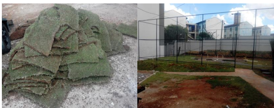
Foto 272 (esquerda)– Peças de grama sintética para campo de futebol, exterior, na obra 2; Foto 273 (direita) – Aspecto de área de lazer (campo de futebol),na obra 2;
