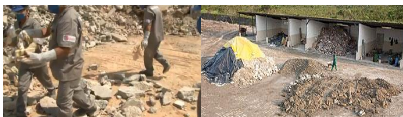
Figura 322 (esquerda) – Triagem manual, na ATT, por operários treinados para o efeito; (direita) – Áreas para armazenamento temporário por naturezas de materiais (Fonte:
