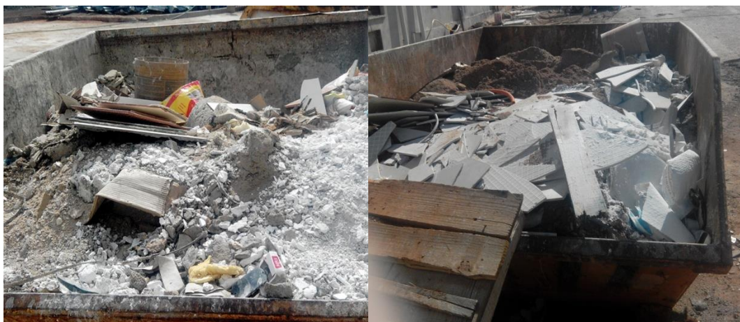
Foto 276 (esquerda)– Contaminação de resíduos em caçamba, na obra 2; Foto 277 (direita) – Contaminação de resíduos em caçamba, na obra do Ipê Branco (Fonte: o pesquisador, 2019)
