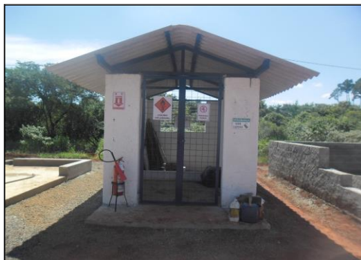
Foto 35 – Depósito de resíduos perigosos, não vislumbrado em obra (Fonte: o pesquisador)
