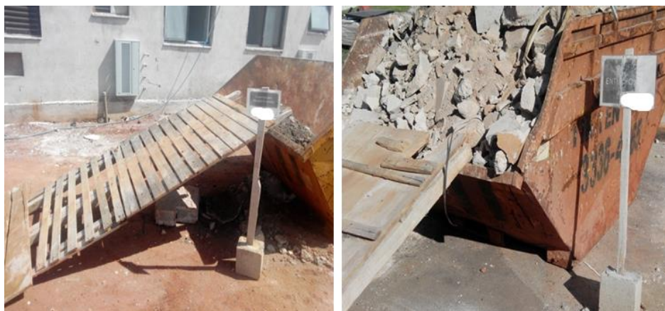
Fotos 132 (esquerda) e 133 (direita) – Resíduos classe A, cimentícios/entulhos, sofrendo armazenamento final em caçambas próprias para o efeito, na obra 2 (o pesquisador, 2019);
