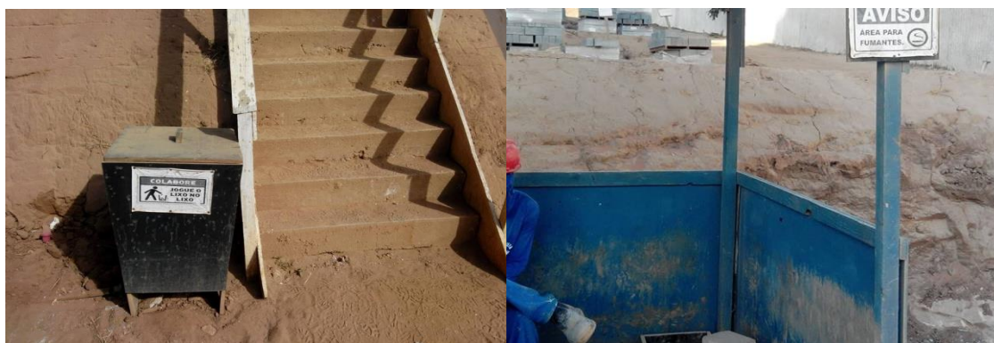
Foto 22 (esqu.) - Lixeiras colocadas em pleno local dos trabalhos; Foto 23 (dir.) – Área específica para fumantes (Fonte: o pesquisador)
