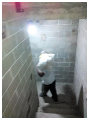
Foto 66 – Resíduos de gesso sendo transportados manualmente desde o 1º andar até o térreo, por funcionário, dentro de saco de cimento (Fonte: o pesquisador, 2019)
