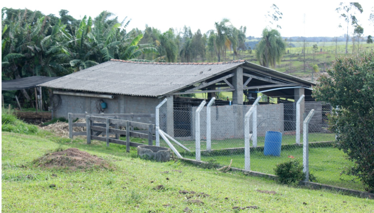
Fotografia B3. Mangueira da UD2. Angatuba, SP. 04/01/2020. Fonte: SANTI, T.
