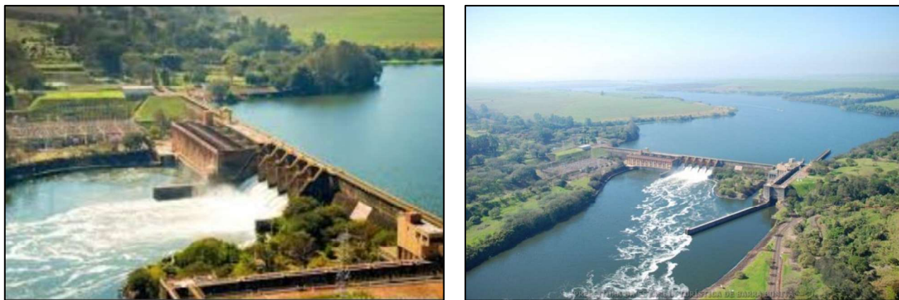
Figura 7.33: Barragem do Rio Tietê no município de Barra Bonita (-22°31'10"; -48°32'.04"): Fonte (BARRA BONITA, 2019)
