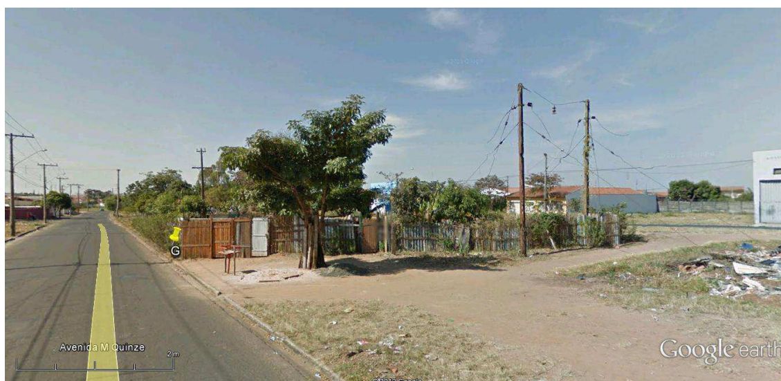
Figura 23 – Vista de frente do local de produção do agricultor G . Detalhe dos entulhos próximos ao local.
