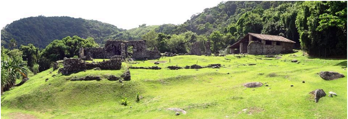
FIGURA 1 – FOTOGRAFIA DAS RUÍNAS DO ENGENHO DO GOVERNADOR (O PRIMEIRO DA CAPITANIA DE SÃO VICENTE -1533).
