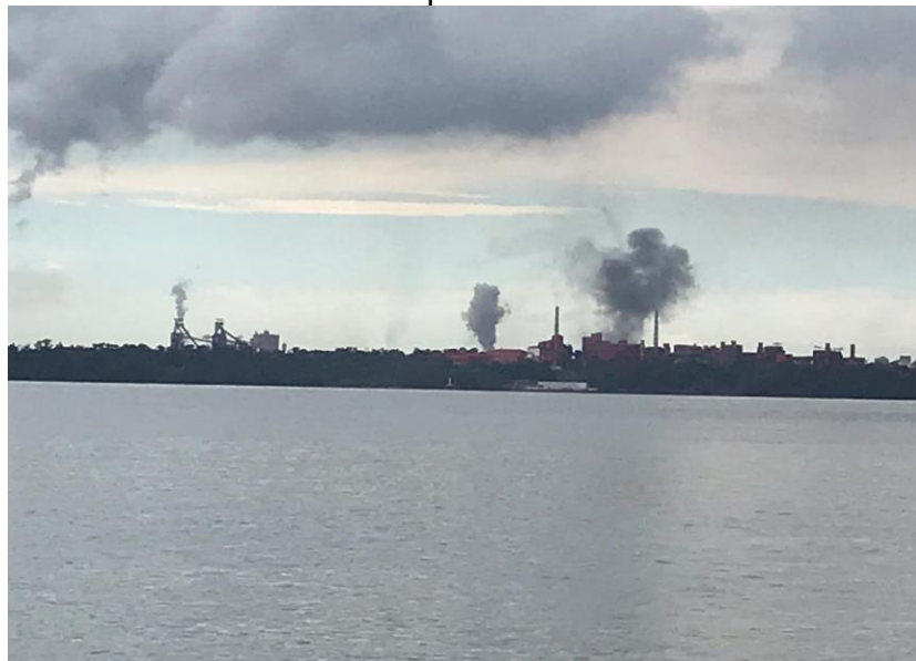
Figura 6 - Foto panorâmica do complexo do Tubarão e pontos de emissão do pó preto
