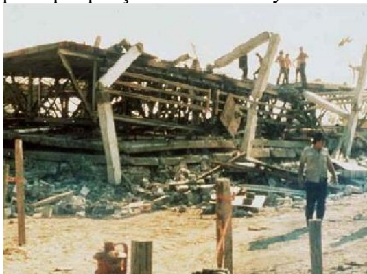
Figura 1: Ruptura por punção - Harbour Cay Condominium (1981).
