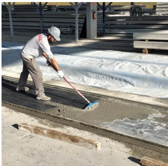
**Figura 4-2 Aplicação do desmoldante**
