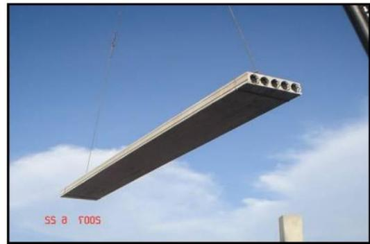
**h) Içamento de uma laje alveolar para posicionamento na obra**
