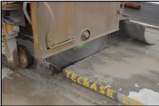
**e) Corte da laje após liberação da protensão**
