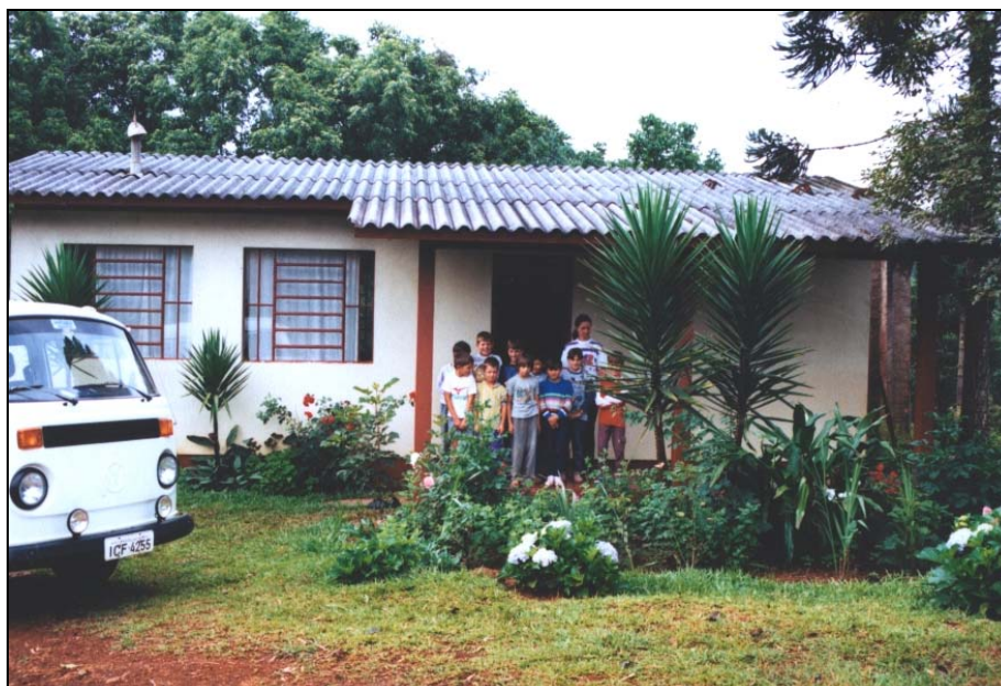
Figura 13 – Prédio Escolar – E.M.E.F. N.S a . de Lourdes - Marcelino Ramos.
