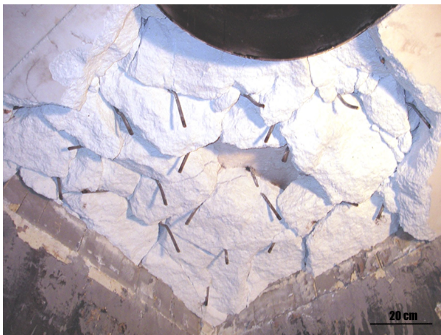
Figura 4.2: Parte da zona de combustão de uma unidade de aquecimento em uma refinaria de petróleo. Retirado de [25]. Escala aproximada.
