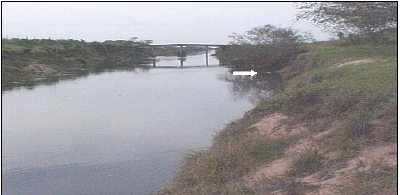
Figura 3: Estação 2, ponte de concreto localizada sobre o trecho dragado do rio Gravataí, na fazenda Juca Barcelos, município de Glorinha, RS.
