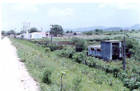
Olhando à direita encontramos a primeira Estação de Tratamento de Água da cidade, localizada no bairro do Açude, ainda do tempo em que a água utilizada era do açude Paulo Bastos, que fica ao lado. Olhando na direção contrária, avistamos a ETA atual que utiliza a água do açude Jerimum.
