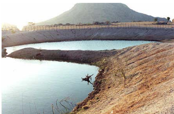
"Lagoa de decantação" (?), depósito de dejetos oriundos dos esgotos domésticos e comerciais de boa parte da cidade. Fica localizado no Gil Bastos, próximo a uma passagem do rio que deságua no açude do Mici.
