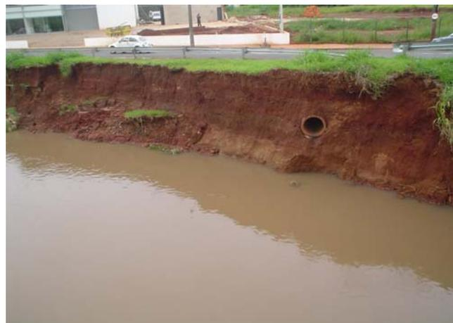
*Figura 65: Rotatória do Cristo – Ribeirão Monjolinho- Detalhe: Erosão*
