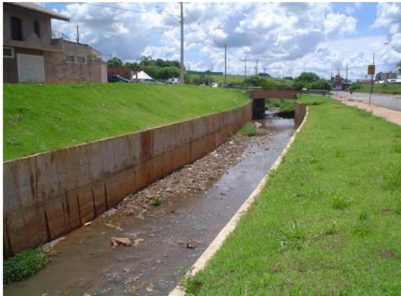
*Figura 46: Córrego do Gregório – Detalhe do fundo do córrego canalizado
