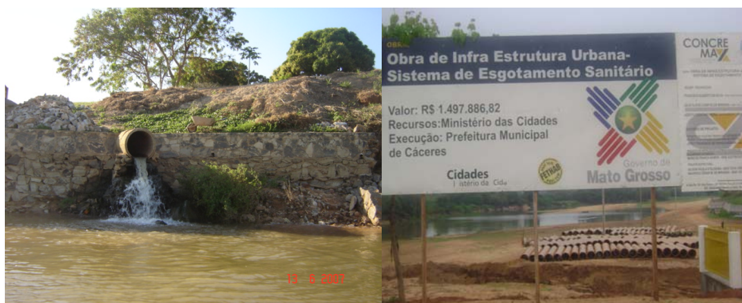
Figura 12 - Despejo de esgoto in natura na zona urbana de Cáceres, MT e Projeto da PMC em execução na Baía dos Malheiros.
