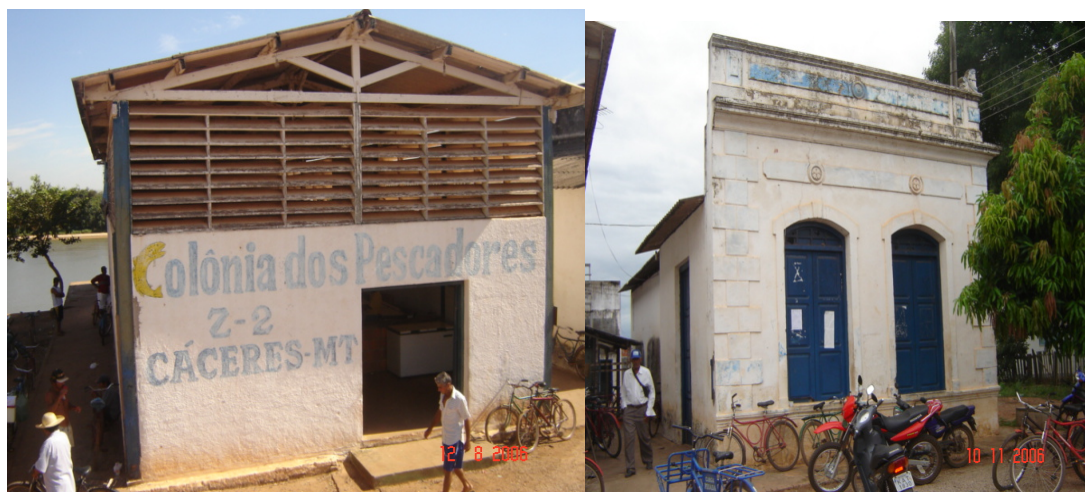
Figura 16 - Sede Administrativa da Colônia Z-2 de Cáceres/MT.
