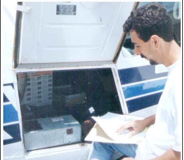
Montagem do equipamento no interior da aeronave
