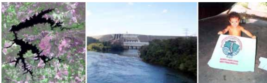
FIGURA 5.12. Usina Hidrelétrica de Manso. Imagem e fotos do MAB.
