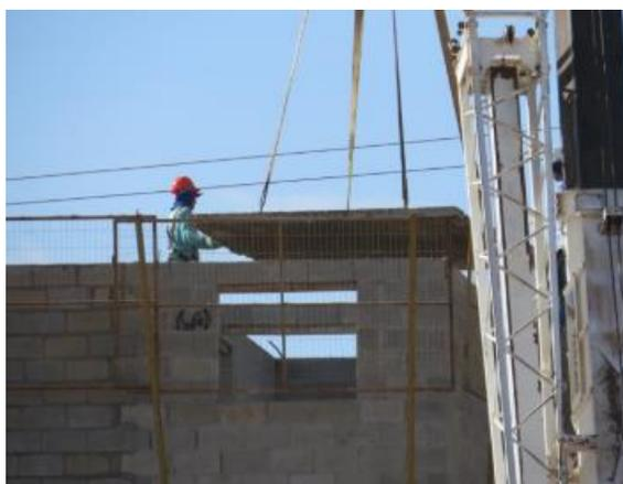
(a) Içamento de painel com dispositivo com laço interno
