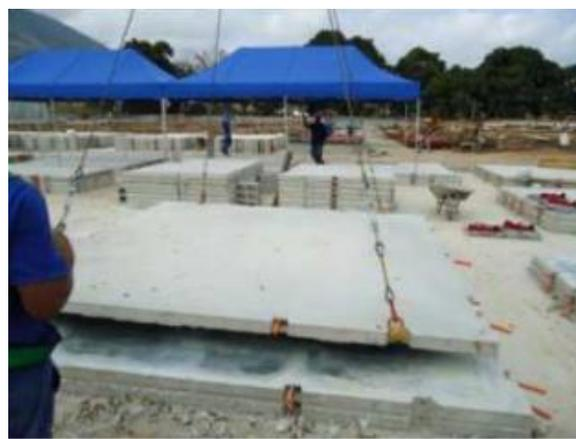
(b) Içamento de painel com dispositivo especial para levantamento lateral
