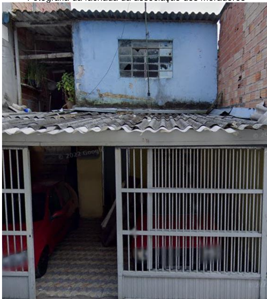
Fotografia da fachada da associação dos moradores
