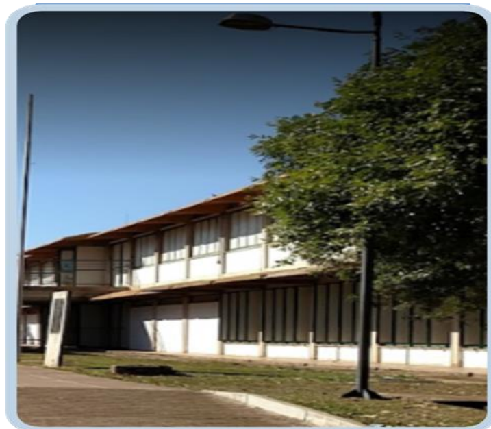
Figura 4: Visão da lateral do prédio de dois andares
