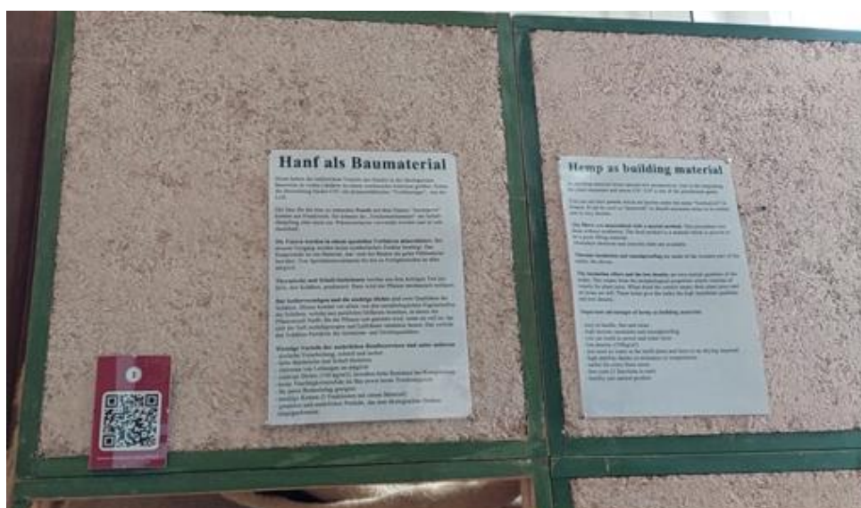
Figura 5 – Parede de fibra de cânhamo
