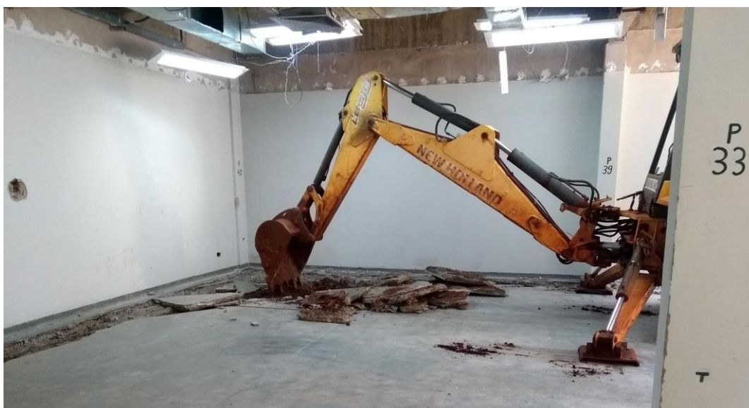
Figura 18 - Demolição área interna
