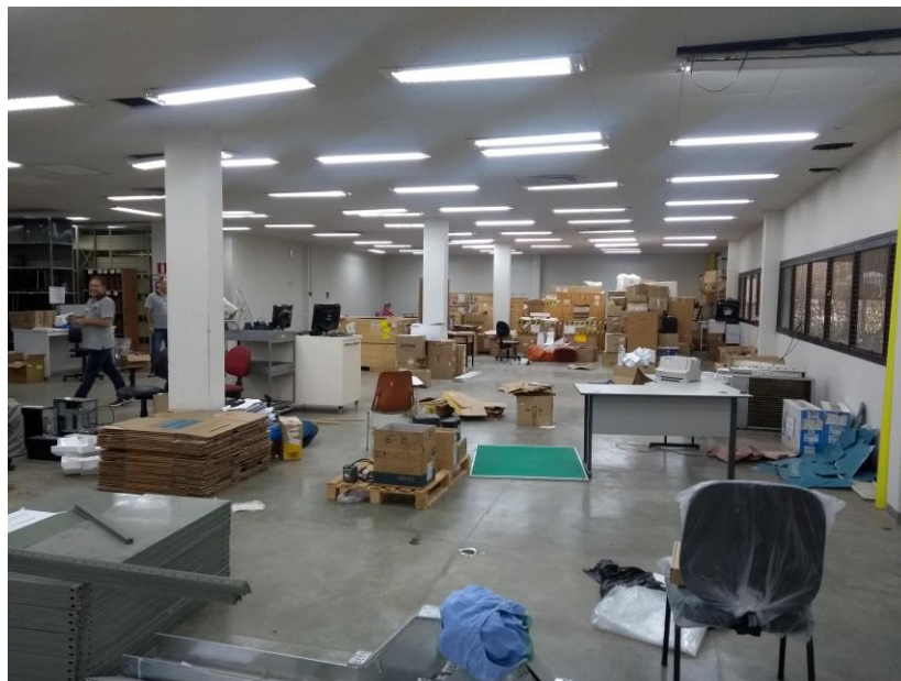
Figura 6 - Arquivo de radiologia (antes da reforma)
