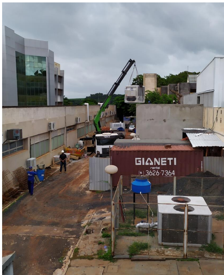
Figura 12 - Acesso a obra por rua externa
