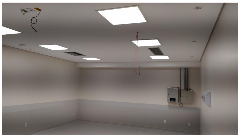
Figura 27 - Forro de gesso
