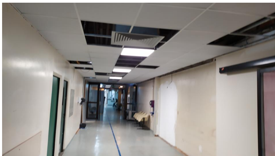
Figura 28 - Forro removível (inacabado)
