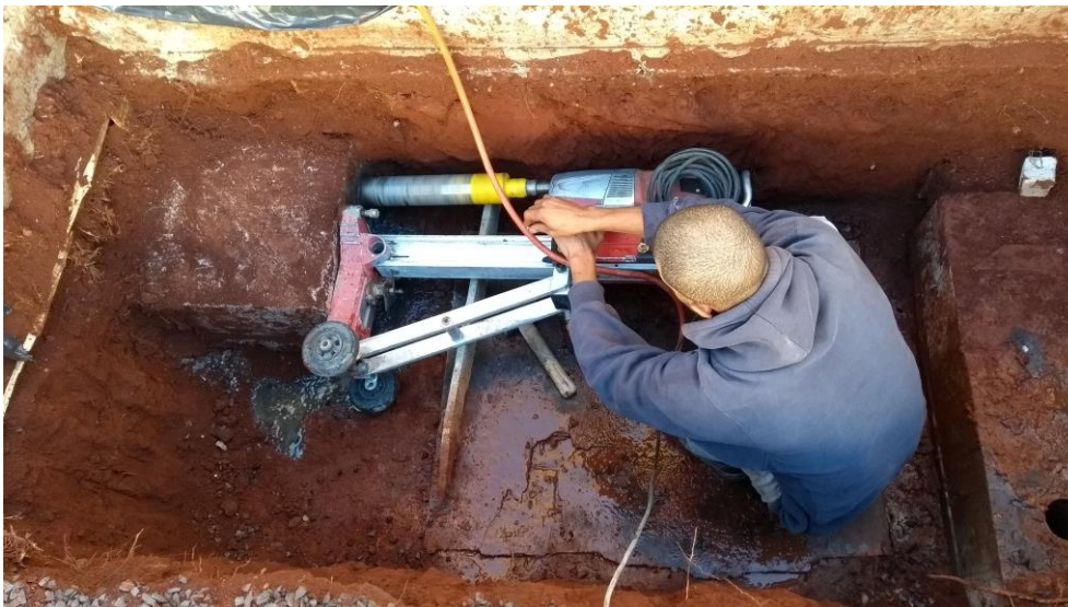
Figura 21 - Ensaio sapata concretada
