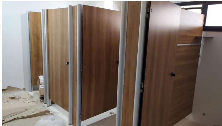
Figura 37 - Portas do banheiro
