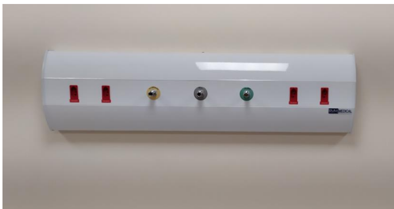
Figura 32 - Tomadas por leito régua R-4
