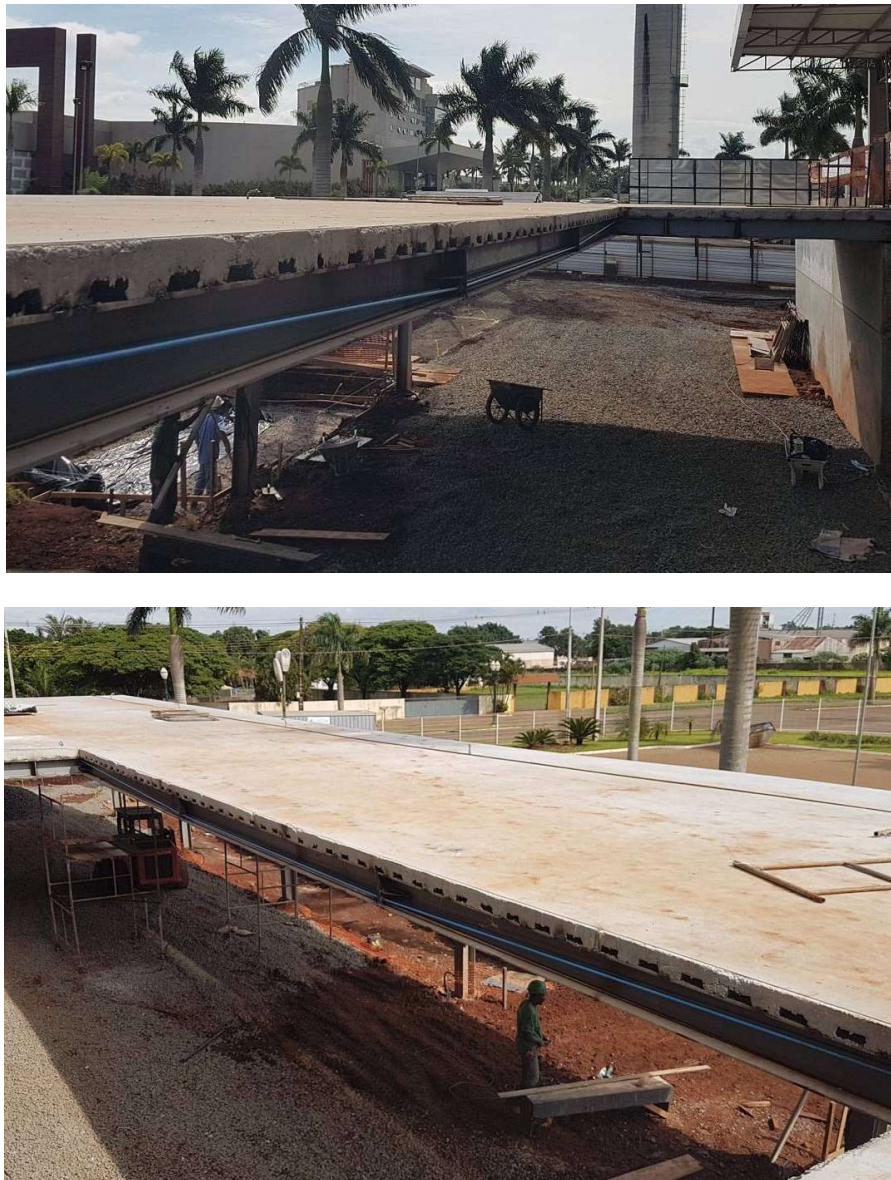
Figura 2.28: Estrutura em viga mista de aço e concreto prontedida do Paraná Fashion Hall
