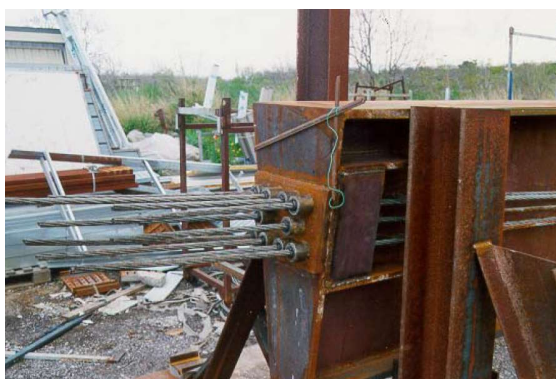
Figura 3.31: Ancoragem da cordoalha com cunhas e chapa de ancoragem
