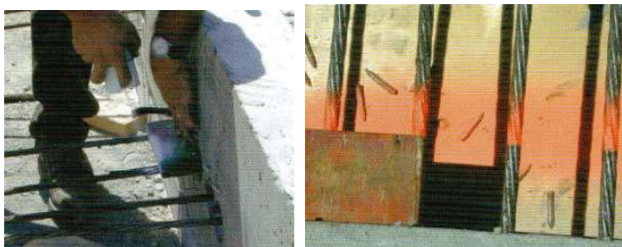
Figura 3.32: Controle do alongamento das cordoalhas
