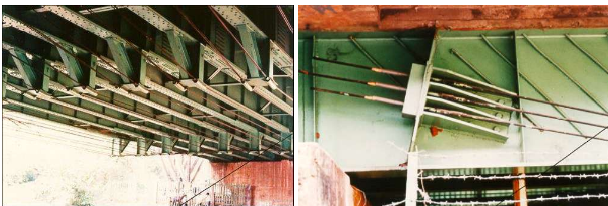
Figura 2.25: Vista inferior e detalhe ancoragem dos cabos na Ponte de Condet
