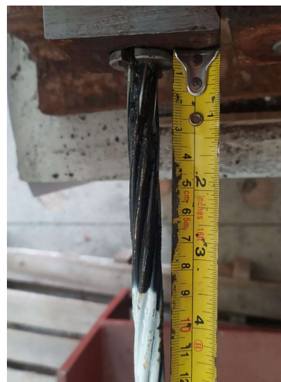
Figura 5.29: Execução da protensão
