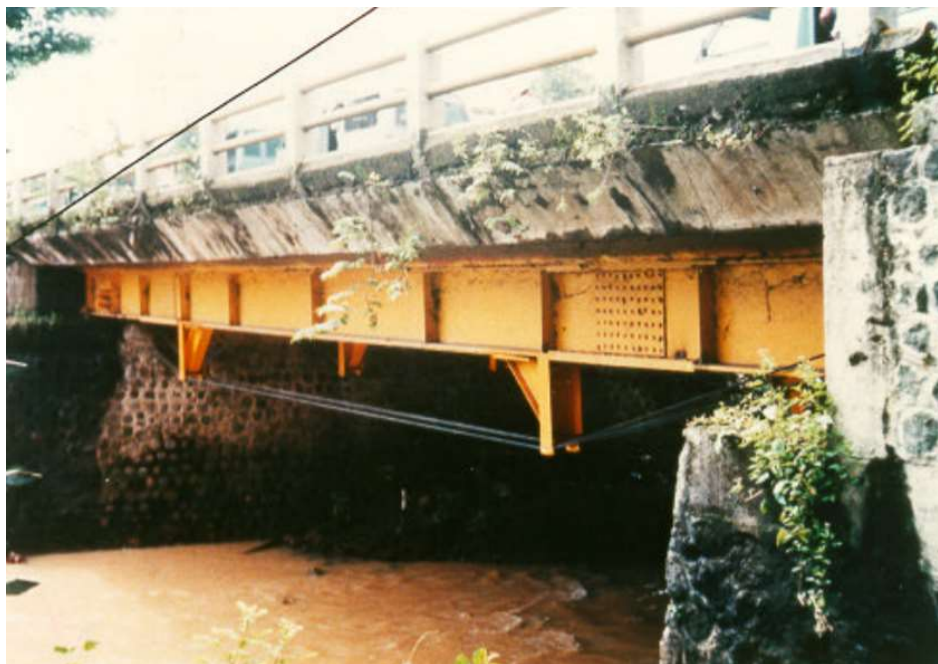
Figura 2.27: Ponte Kemlaka Gede após reforço com protensão externa
