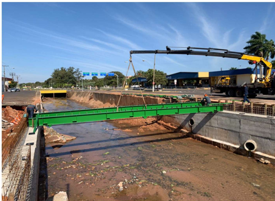
Figura 2.30: Execução da ponte em viga mista de aço e concreto protendida em Lins/SP
