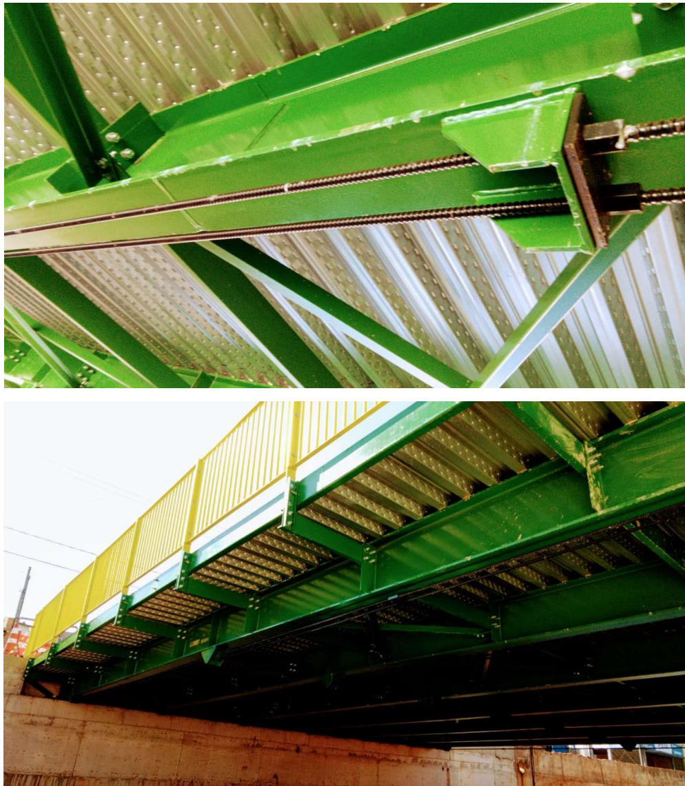
Figura 2.29: Estrutura em viga mista de aço e concreto prontedida da Ponte sobre o córrego Campestre em Lins/SP
