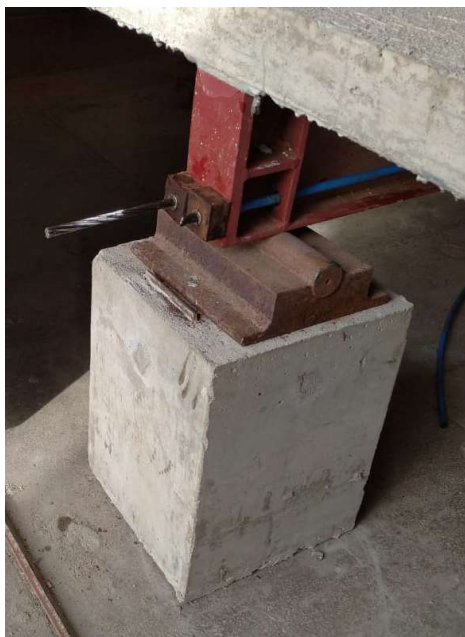
Figura 5.24: Apoio da viga e ancoragens das cordoalhas
