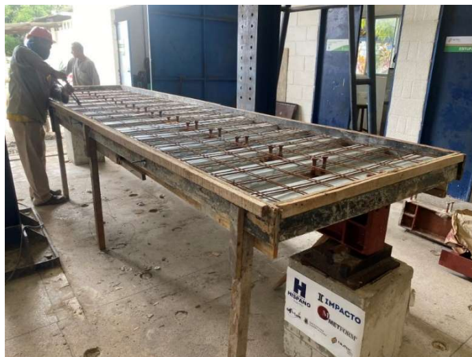
Figura 5.11: Concretagem da VMPP
