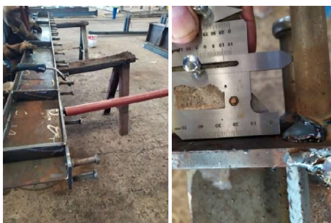
Figura 5.8: Controle de qualidade da solda dos conectores de cisalhamento
