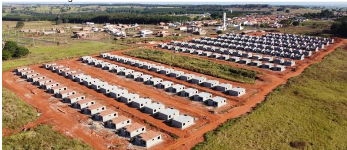
Figura 9 - Vista aérea da obra CDHU em Palestina – SP.
