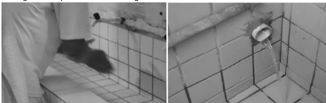
Figura 6 - Aproveitamento da água dos lavatórios nos mictórios dos vestiários.
