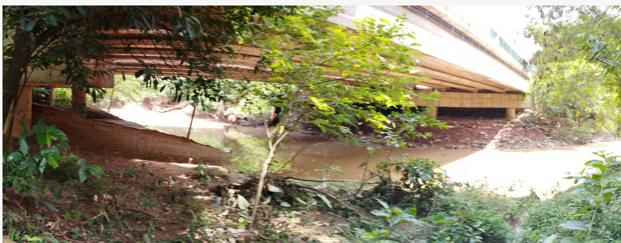
Imagem da Ponte sob o Rio Anhumas, próximo a Rhodia. Fonte Patrik de Oliveira Aprigio, 2023.
