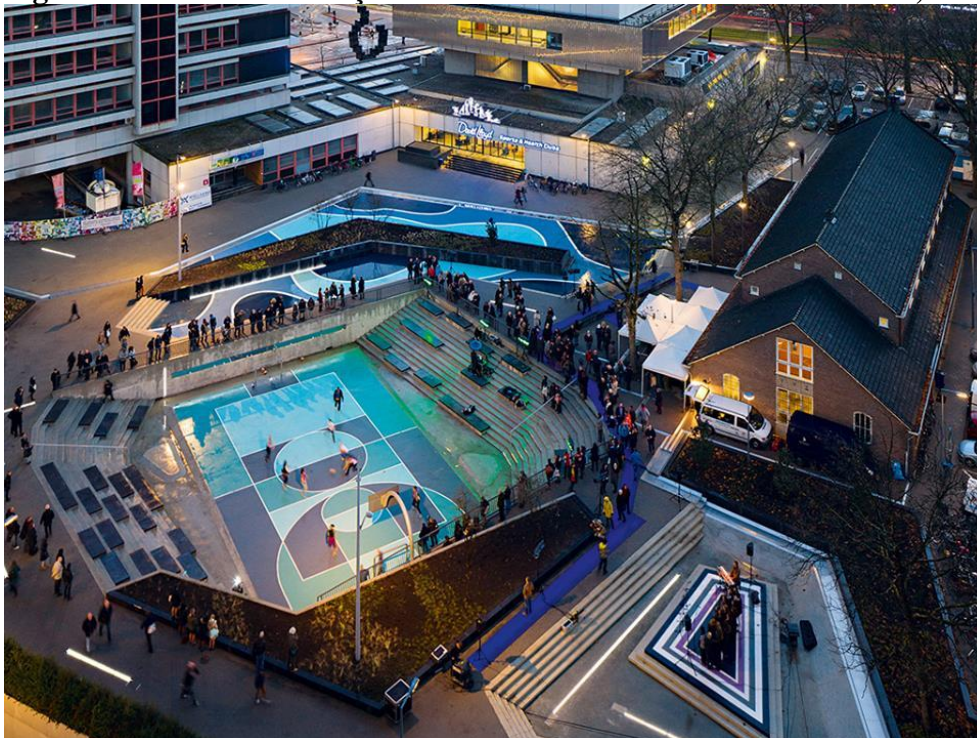
Figura 6 – Bacia de retenção em Rotterdam. Fonte: De Urbanisten, 2012
