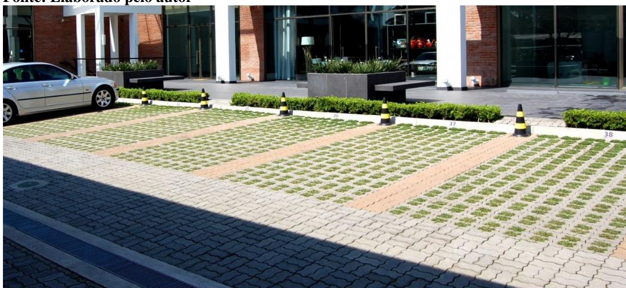
Figura 8 – “Concregrama” associado à piso de concreto intertravado em estacionamento. Fonte: Elaborado pelo autor
