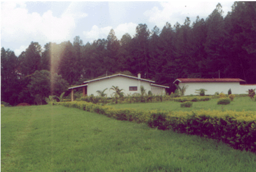
Foto 16 – Casa sede ao fundo e área da sede
