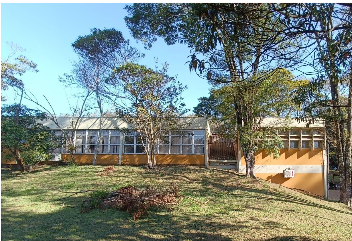
Figura 12. Fachada norte do edifício.
