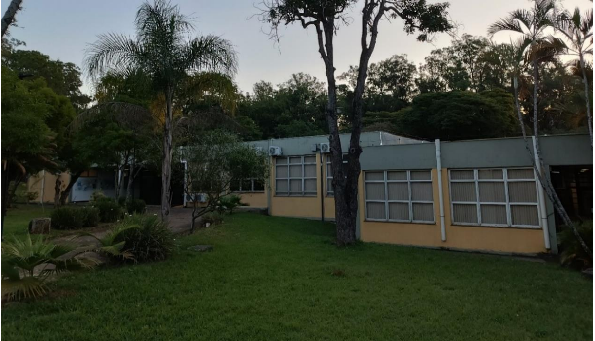
Figura 9. Fachada leste do edifício.
