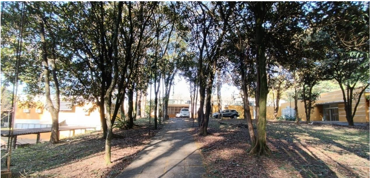
Figura 10. Fachada oeste do edifício.
