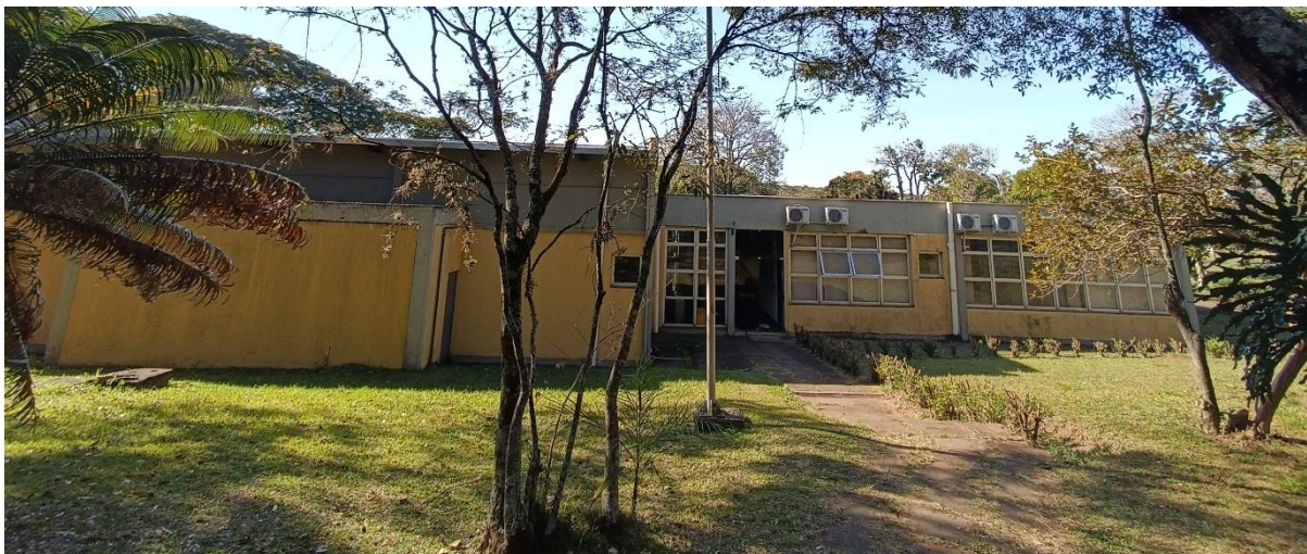
Figura 11. Fachada sul do edifício.
