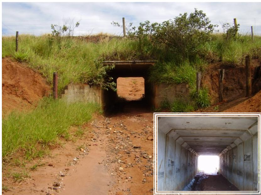
**Figura 6** – Túnel 2 – Passagem de gado sob a rodovia.
