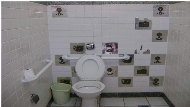
Imagem 22: Banheiro da Oficina Cultural de Uberlândia – MG Fonte: Arquivo pessoal
