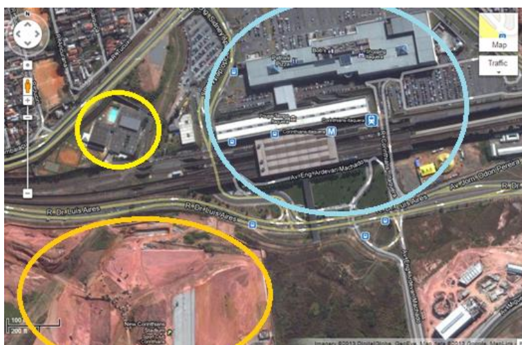
Figura 4: Imagem aérea da localização do CFC. Em amarelo, o CFC. Em laranja (à esquerda, abaixo), as obras do “Itaquerã”. No círculo azul, o shopping, Poupatempo e estação de metrô e CPTM
