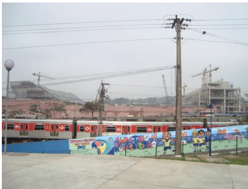
Figura 2: Vista do Estádio de futebol do Sport Club Corinthians Paulista, em construção, e da linha vermelha de metrô da cidade de São Paulo. No muro, grafite realizado pelos adolescentes das medidas socioeducativas e da região de Itaquera nas atividades da Oficina de Grafite oferecida pelo MSE-MA
