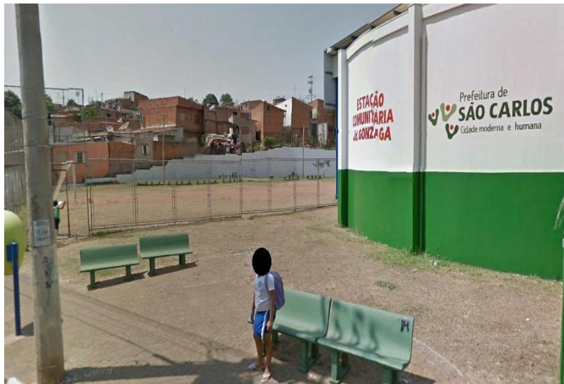
Lateral da Estação Comunitária, que contém uma USF, quadra poliesportiva, espaços para oficinas e parquinho infantil. Fonte: Google Earth.
