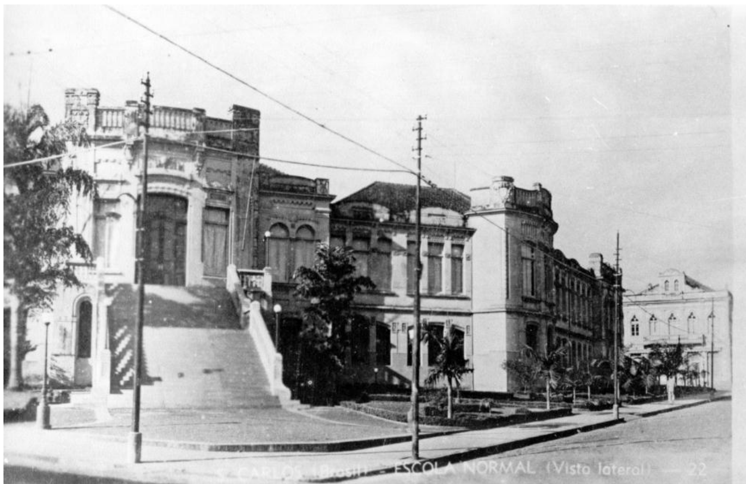
Figura 3: Lateral do Prédio da Escola Normal de São Carlos em 1922
