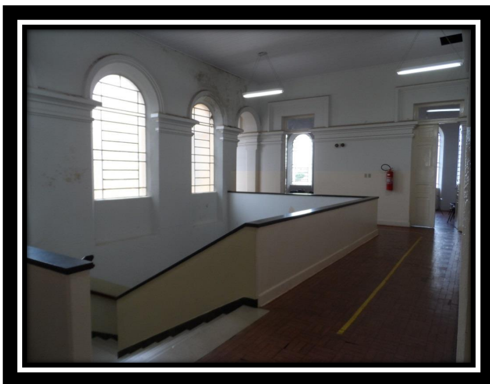
Figura 8 - Espaço interno do prédio dando acesso ao segundo andar onde funciona o Projeto Guri. Fonte: Caroline de Almeida
