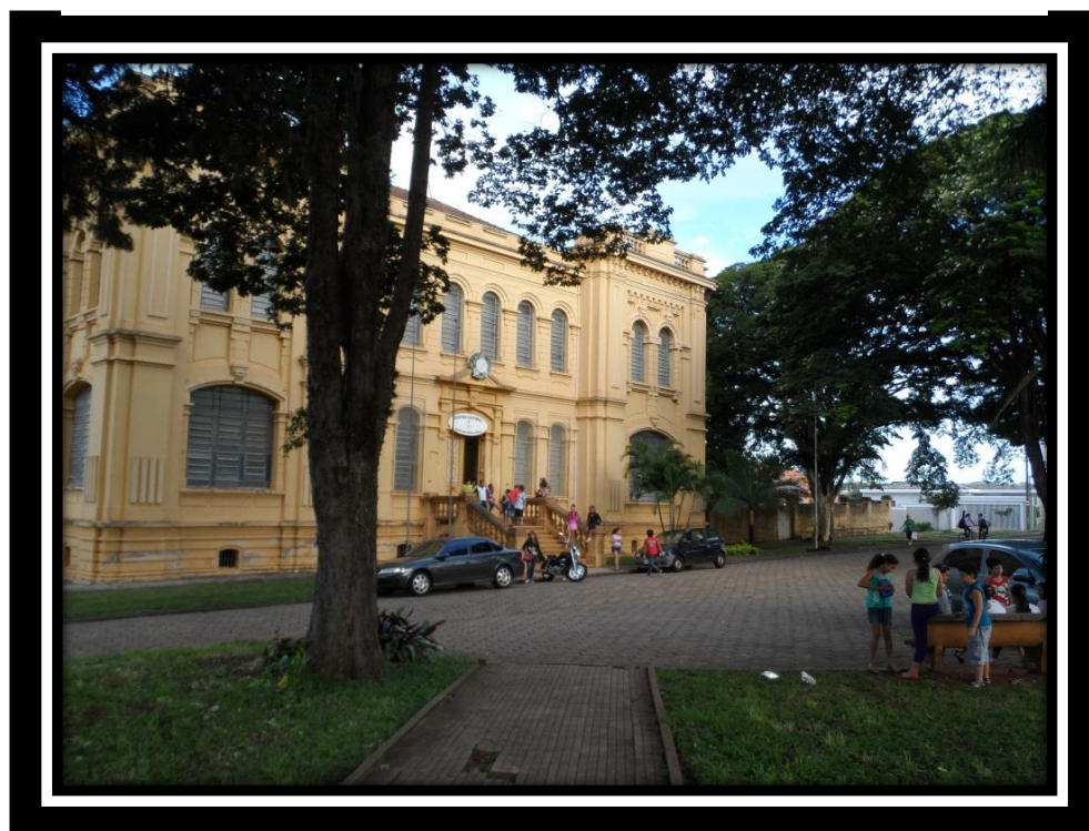
Figura 5 - Atual foto do prédio com a presença dos alunos. Fonte: Pesquisador
